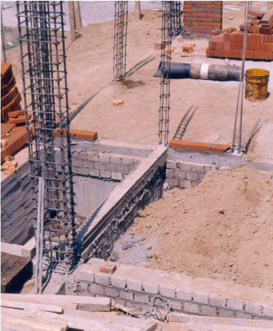
apoyos de concreto armado se ligo con el muro de contención en planta de sótano, los apoyos se desplantan desde una zapata aislada de concreto armado que se sitia desde la plantilla conjuntamente con la piedra braza.
