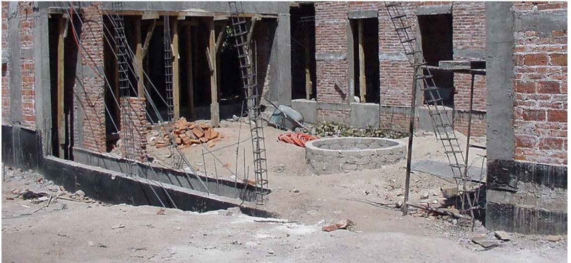
El razonamiento del diseño estructural estableció dividir la estructura a partir de la cimentación en dos cuerpos, localizándose la junta instructiva en el eje f entre 1 y 2. Complementariamente se ubicaría una serie de muros cortante de concreto armado bajo los criterios del diseño arquitectónico establecidos.
