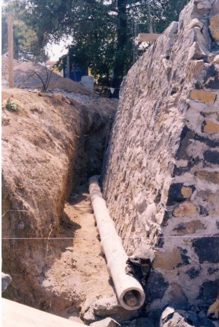
de contención y se realizaron trabajos para aumentar la capacidad de carga del terreno, excavando entre 1 y 1.4 más mezclando material no orgánico con cal en proporción 1:4, humedeciéndolo y compactándolo.
