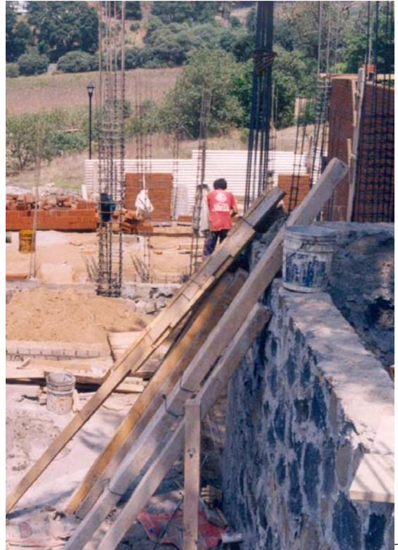
el muro de contención continuándolo por el eje 7 y continuándolo por la colindancia. Se despalmó el terreno en la zona inestable hasta lograr ubicarla en terreno firme, escalonando de nuevo la cimentación a base de piedra braza. Como refuerzo a la estructura se continuaron las contra traves de los ejes 7 y 8 hasta el muro de contención en colindancia.
