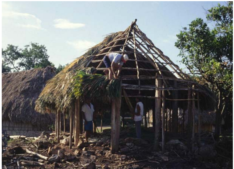
Fig. 15 Construcción de casa en X-Cacal Guardia, Quintana Roo
