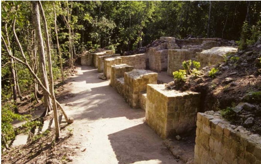
Fig. 235 Fachada este de la Estructura XX, ubicada en el extremo oeste de la Plaza de los Prisioneros. Este edificio fungió, entre otros, como acceso hacia el conjunto palaciego
