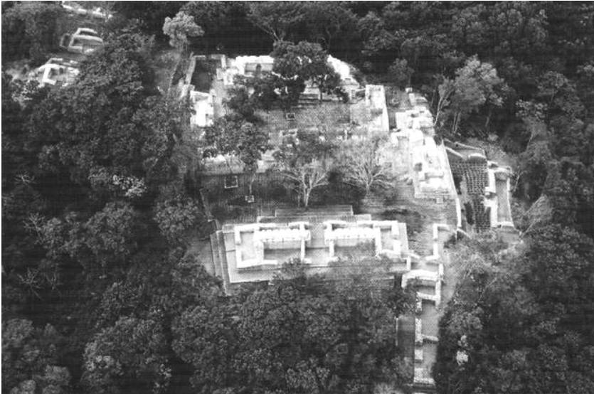
Fig. 164 Vista aérea del conjunto Los 27 Escalones, Kohunlich, desde el norte (Nalda 2004a:16)
