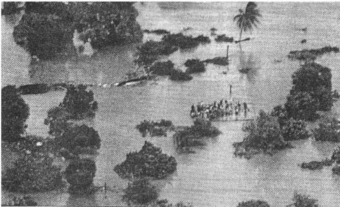
Figura 3.4 Casas totalmente inundadas en San Antonio Coronado Gutiérrez Zamora
