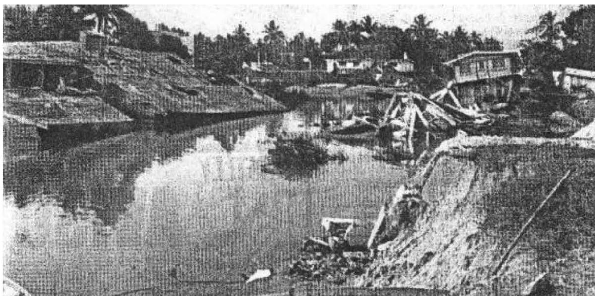
Figura 3.1 Daños en las viviendas de la Villa Tecolutla, por la inundación de 1999.
