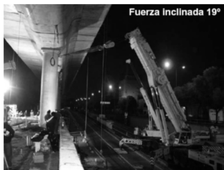
Fig. 4.1.11. Pruebas de tracción lateral con una grúa de 500 t (IINGEN 2005)
