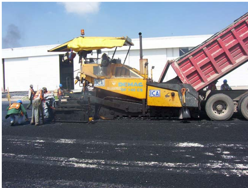
Fotografía I.8.- Colocación de mezcla asfáltica con pavimentador
