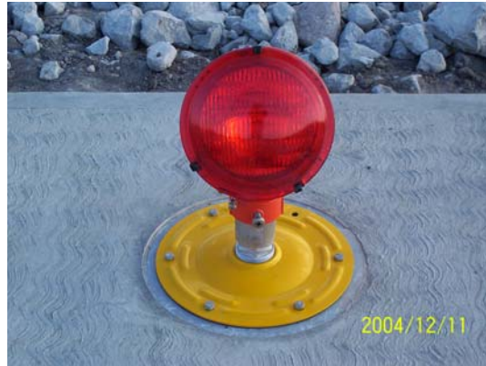
Fotografía V.9.- Unidad de aproximación de luz color rojo.
