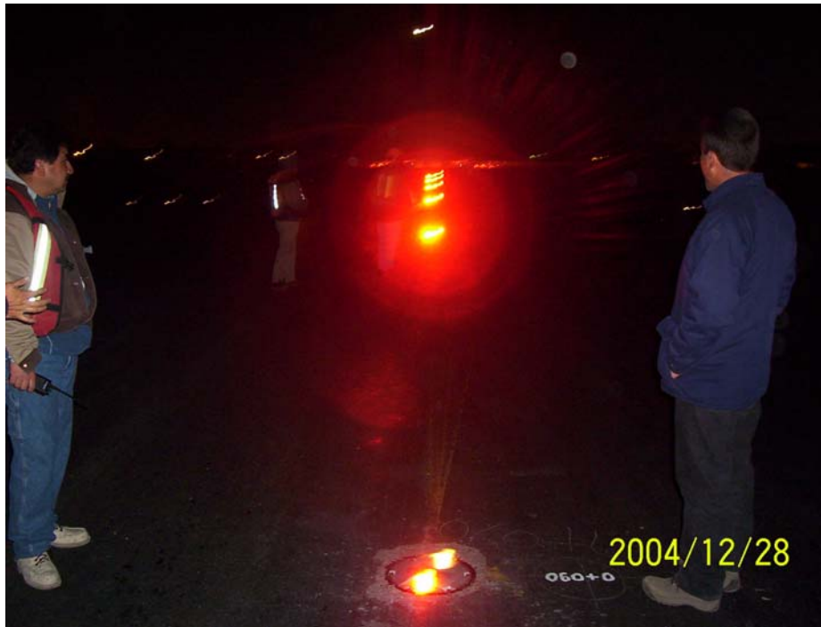
Fotografía V. 43.- Luces de barra de parada.
