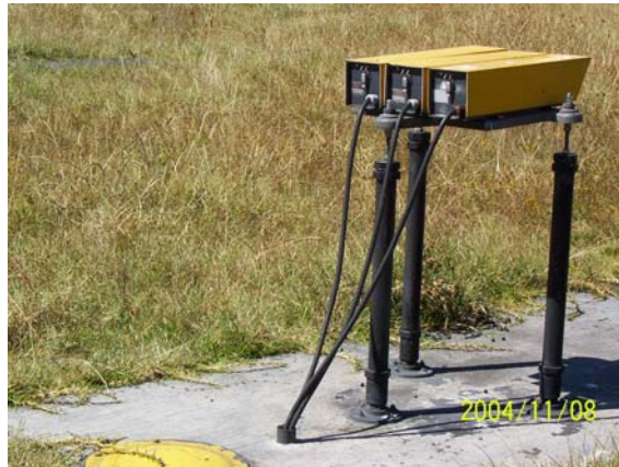
Fotografía V.3.- Antiguo gabinete del PAPI
