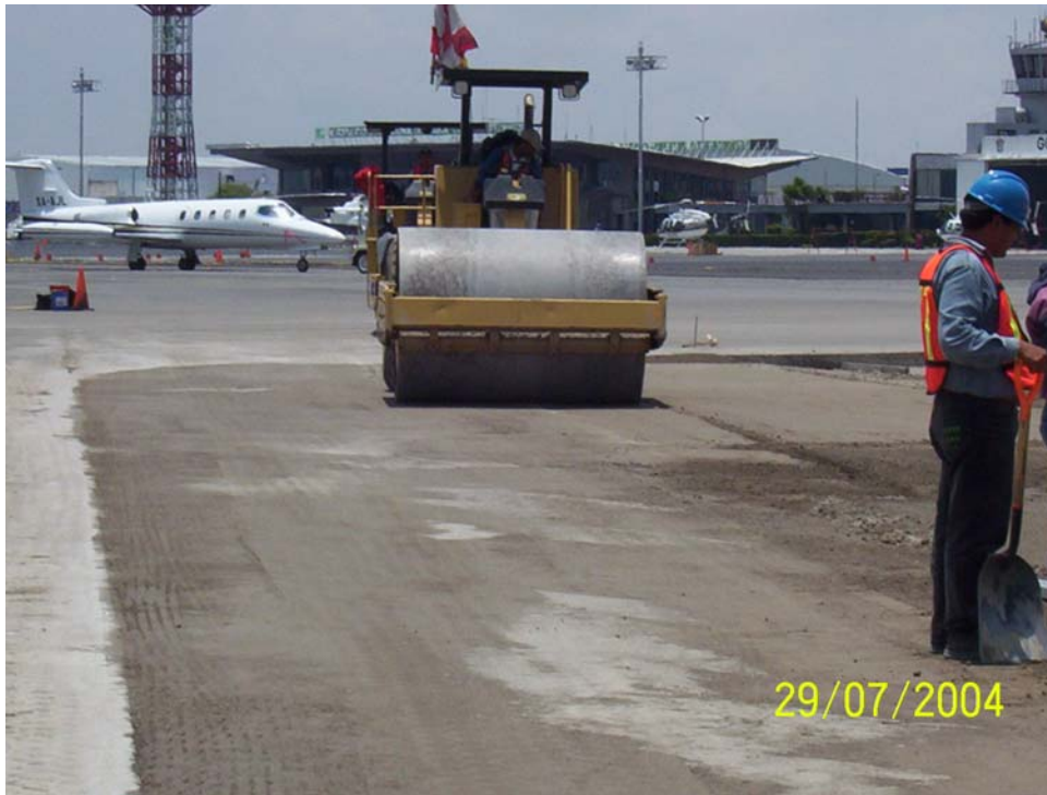
Fotografía II.5.- Compactación de base en rodajes.
