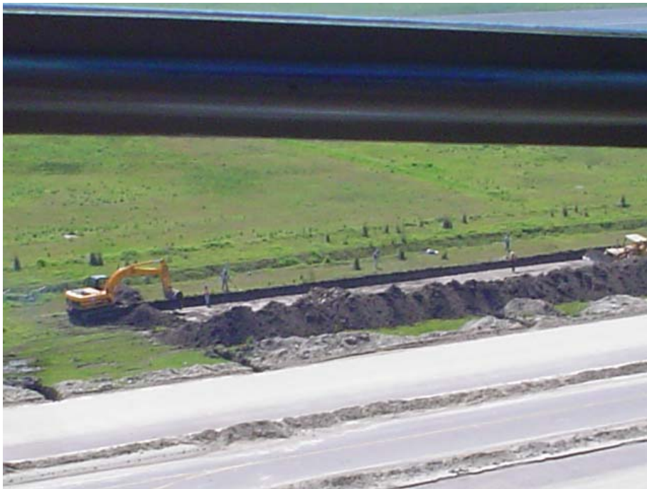
Fotografía IV.1.-Excavación para la construcción de camino de servicios.
