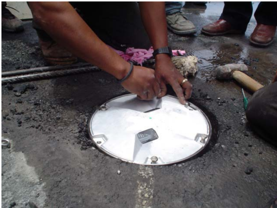
Fotografía V.41.- Fijación con tornillos de unidad rasante para eje de rodaje
