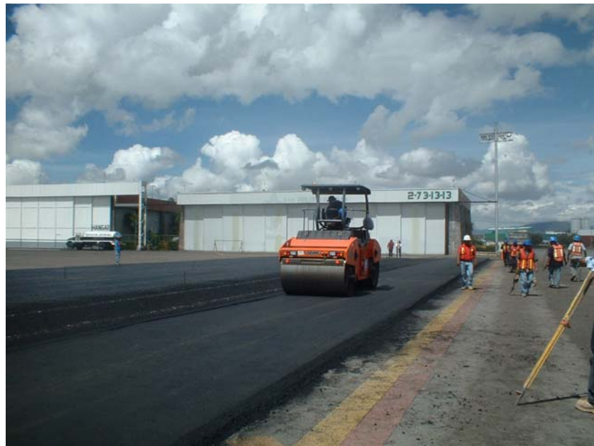
Fotografía III.2.- Compactación de carpeta asfáltica en plataforma.
