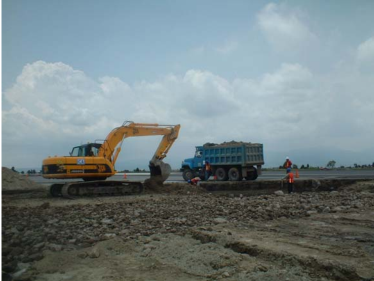
Fotografía II.3.- Excavación con retroexcavadora y carga a camiones
