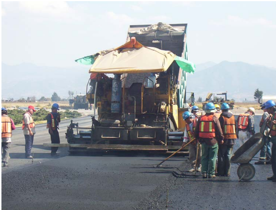
Fotografía I.14.- Colocación de mezcla asfáltica en acotamientos.
