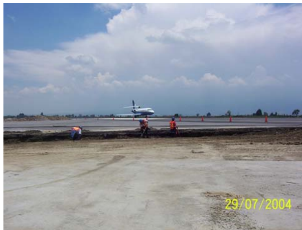
Fotografía II.4.- Capas sub base y base en plataformas.
