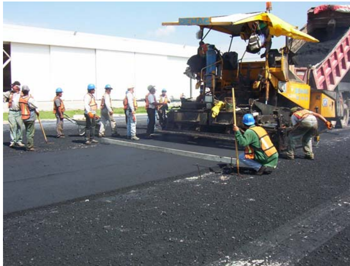
Fotografía I.11.- Paso de regla de aluminio de 5 m de largo en la proximidad del pavimentador.
