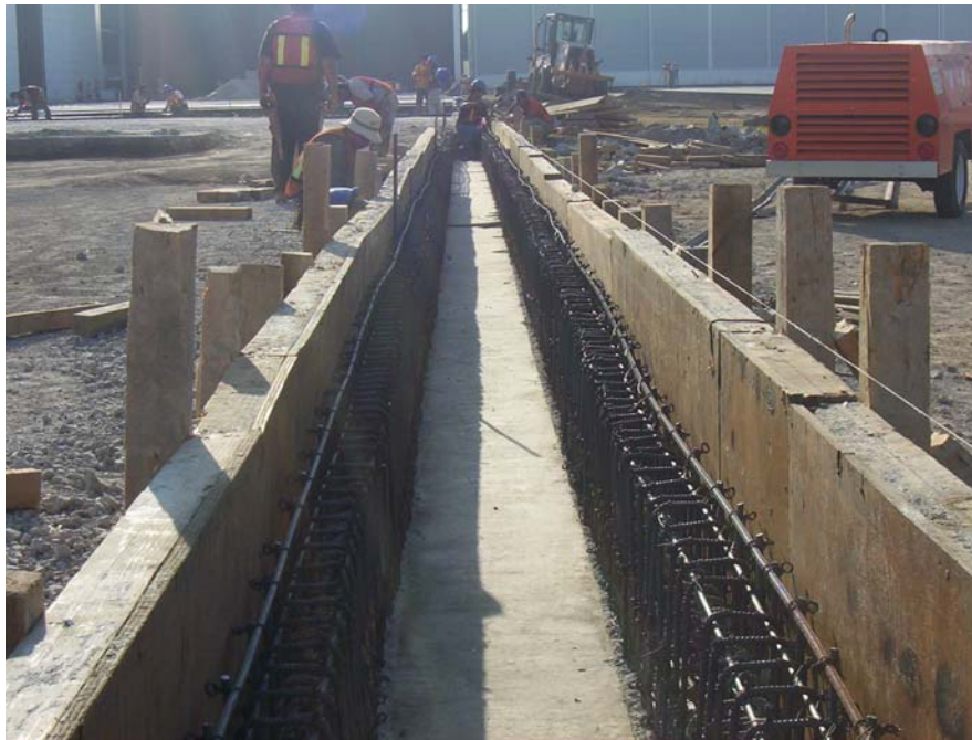
Fotografía II.8.- Armado y cimbrado para canal de aguas pluviales.
