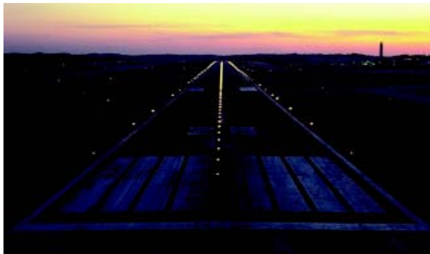
Fotografía V.37.- Luces de eje de pista.
