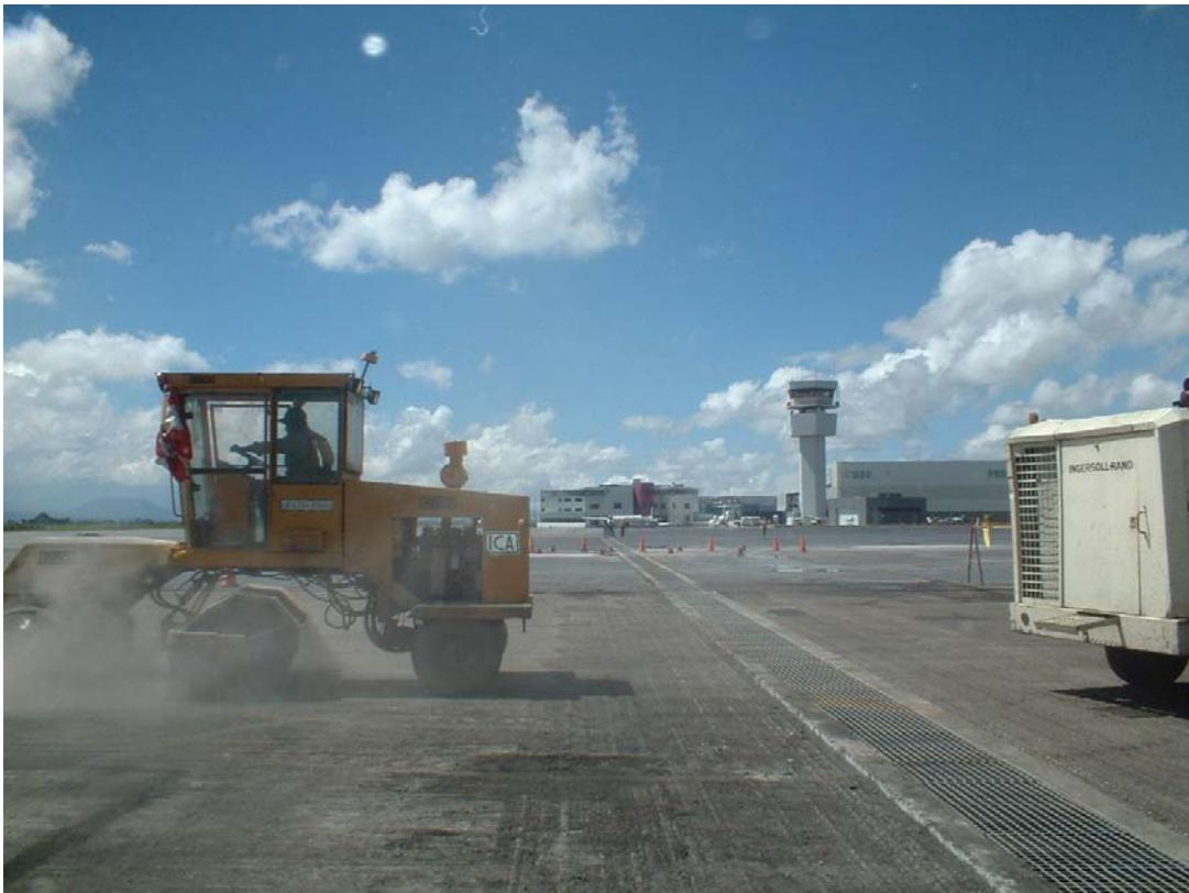
Fotografía I.2.- Limpieza de la superficie fresada con barredora autopropulsada y compresor de aire.
