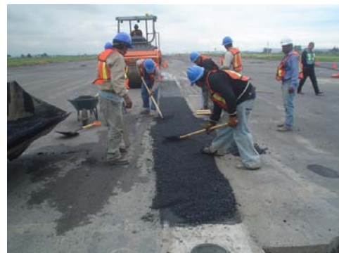
Se coloca la malla geotextil y se rellena las zanja con carpeta asfáltica.
