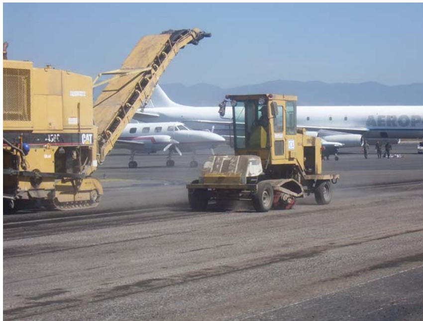
Fotografía II.1.- Fresado y limpieza en calles de rodajes.
