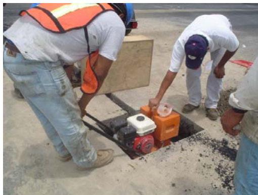
Compactación del piso de la excavación.
