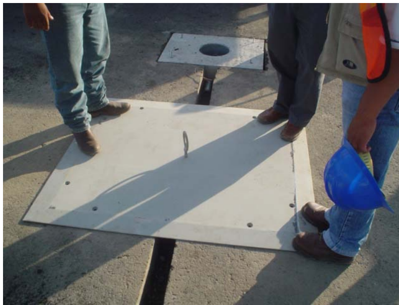
Fotografía V.42.- Placa para cubrir hueco que alojará cimiento registro.
