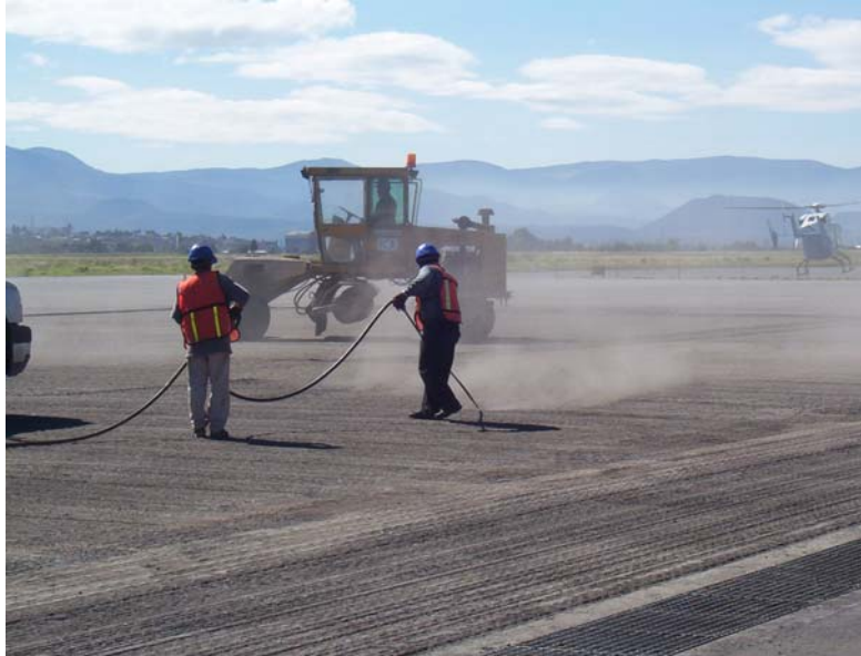
Fotografía III.1.- Limpieza de material producto del fresado con chiflones conectados a compresor de aire.
