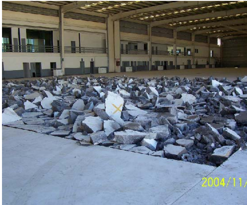
Fotografía III.4.- Losa de plataforma demolida.
