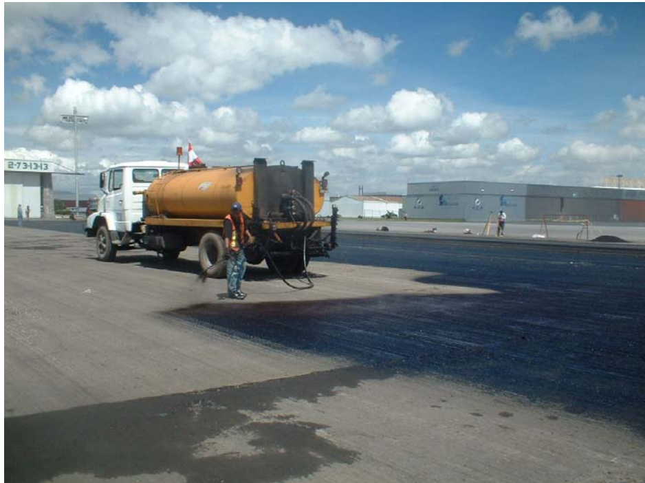
Fotografía I.3.-Riego de liga con petrolizadora empleando bacheador.
