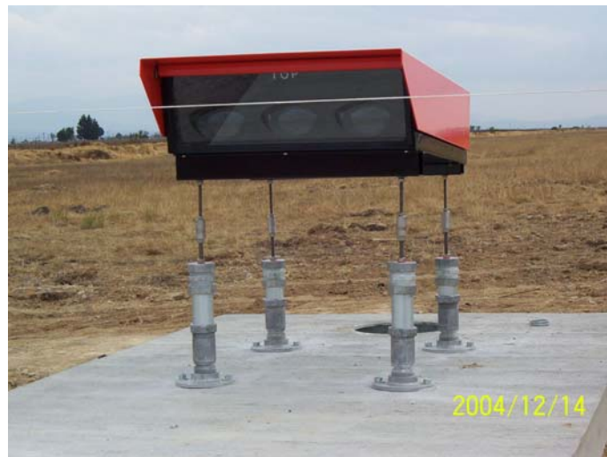
Fotografías V.4 y V.5.-Actuales gabinetes del PAPI
