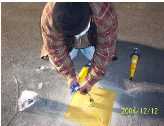
Fotografía V.48.- Instalación de unidad de borde de rodaje
