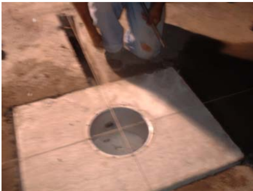
Alineación del cemento registro.
