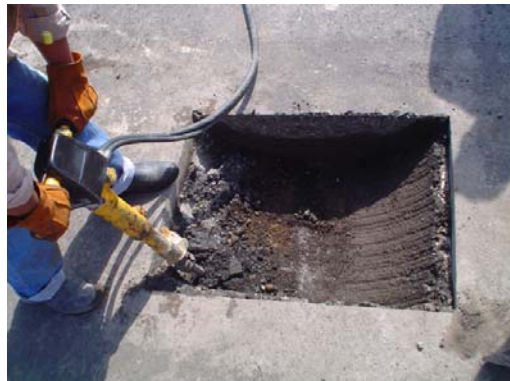
Demolición y remoción del pavimento sobrante.
