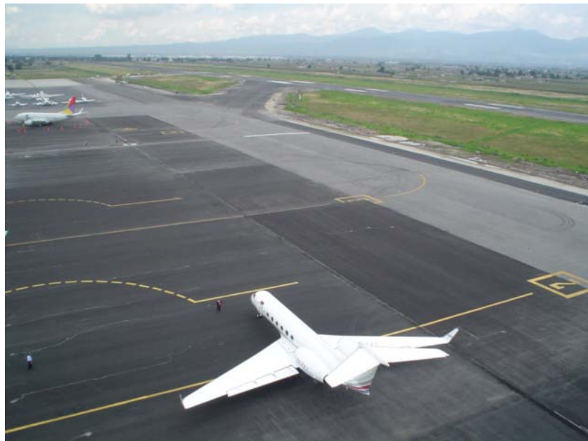
Fotografía III.3.- Plataforma reencarpeta y con sello de protección anticarburante y pintura.
