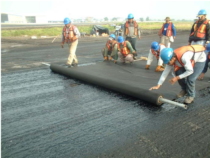
Fotografía I.4.- Colocación de membrana geotextil por método manual.
