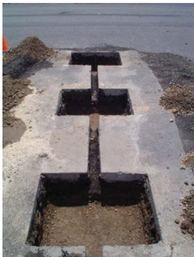
Corte y perfilado del lugar del cimiento registro y zanja de cableado para 3 unidades.
