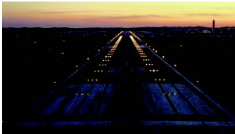
Las luces se encuentran listas para su funcionamiento.
