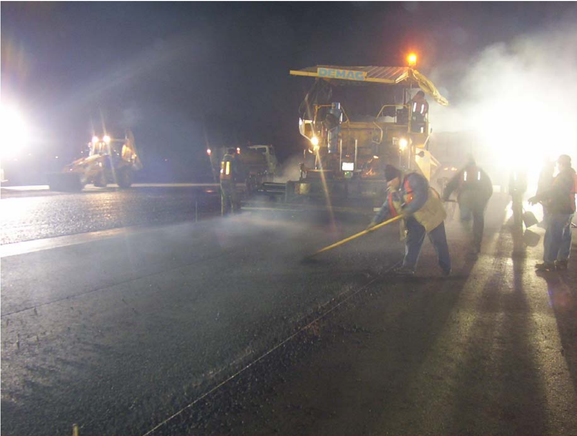
Fotografía I.9.- Colocación de mezcla asfáltica en turno nocturno.
