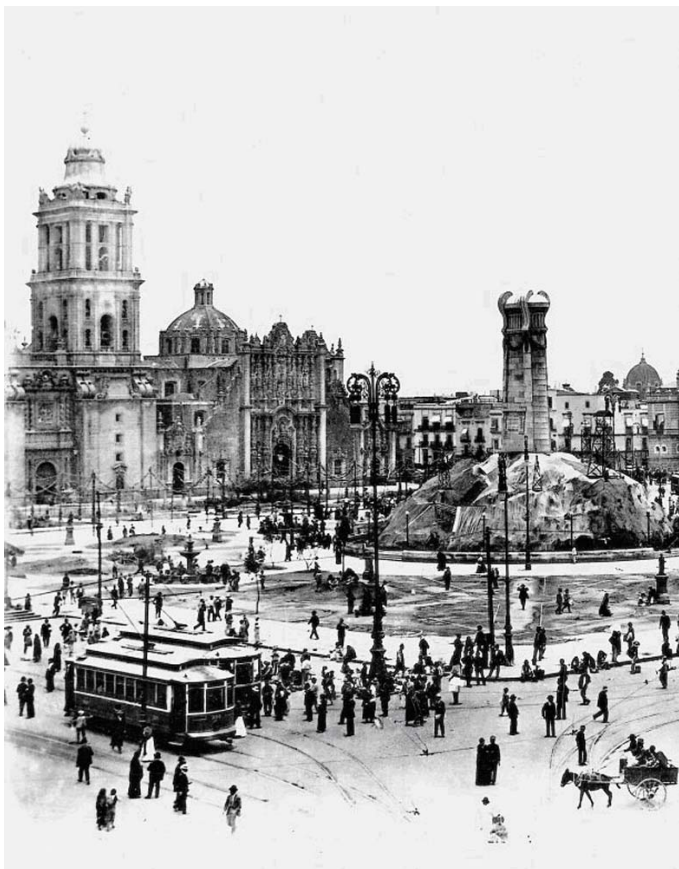
Imagen 28 Se observa en la imagen el cambio de la Plaza Mayor por la instalación de los tranvías eléctricos, sin eliminar el caos que reinaba en el área.
