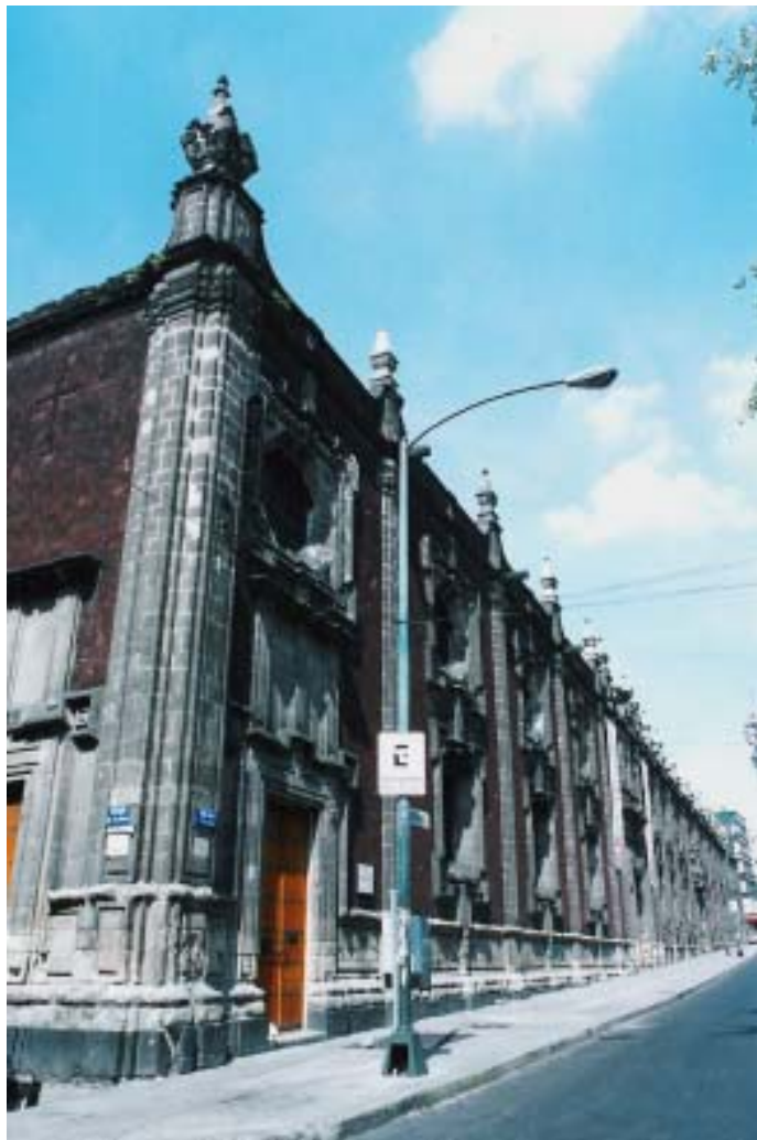
Foto 26. Zona 9, Vista de la fachada principal del colegio de las Vizcaínas, se aprecia las dimensiones del inmueble.
