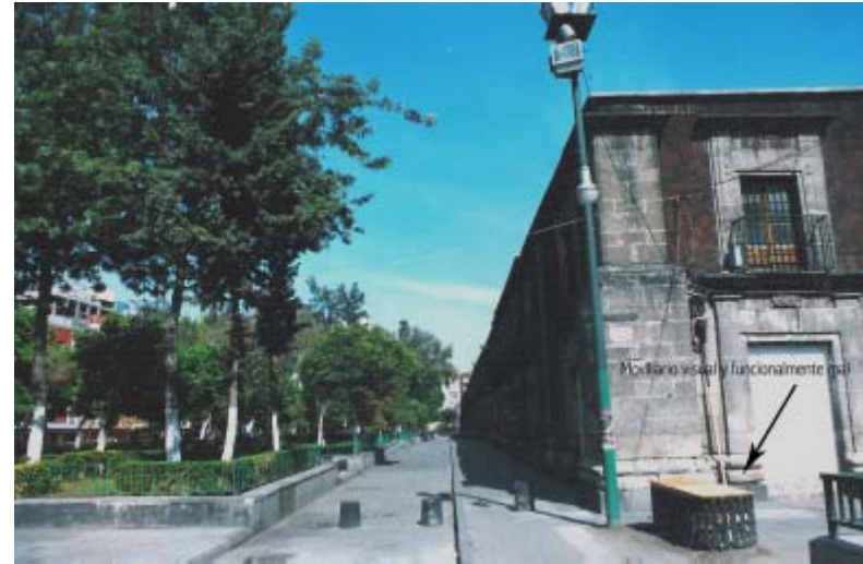
Foto 11. Zona 3, Vista del pasillo norte, que flanquea a la parte central de la plaza, dividida en dos zonas, arroyo vehicular y la acera, aspecto absurdo ya que esta cerrada a la circulación vial.
