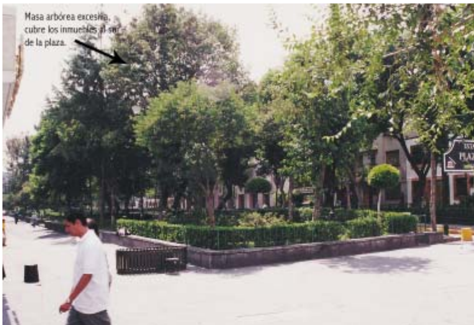
Foto 4. Zona 2, Es una zona de transición, actualmente tiene una jardinera que divide el espacio, impidiendo el desarrollo de actividades y la continuidad. Es un foco de inseguridad y suciedad por los indigentes que viven en ellas.
