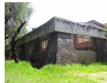
Vista exterior (comedor)
