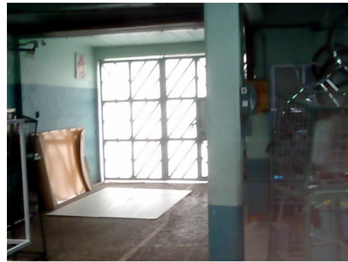
Fotografía 11.- Estirenos sin pegar en el piso
