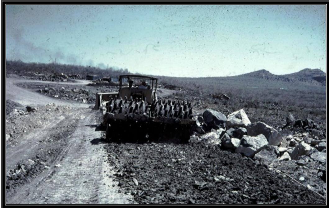
**Figura 19. Rodillo Pata de Cabra, jalado por un tractor D-8.**
