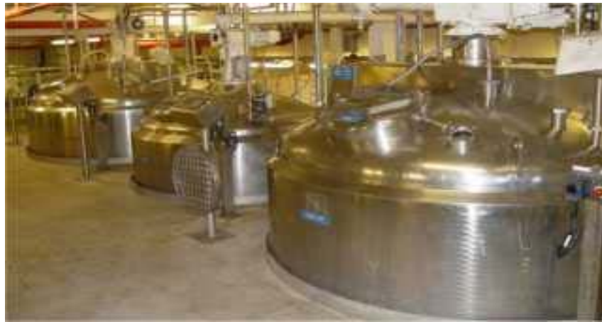
Figura 5.8 Domo de tanques de almacenamiento y/o fabricación de productos cosméticos (Used Equipment Sales Surplus Stock 2005) 28
