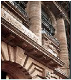
Figura 3. Fachada del Banco de México, Cd. de México, D. F.
