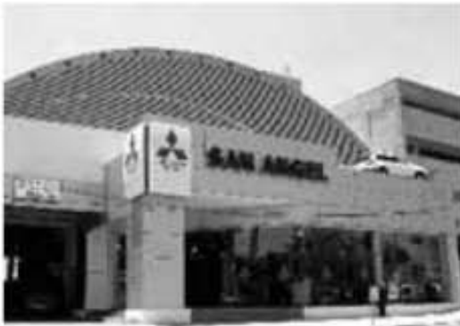
Vista del acceso
