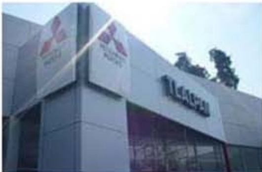
Vista del acceso
