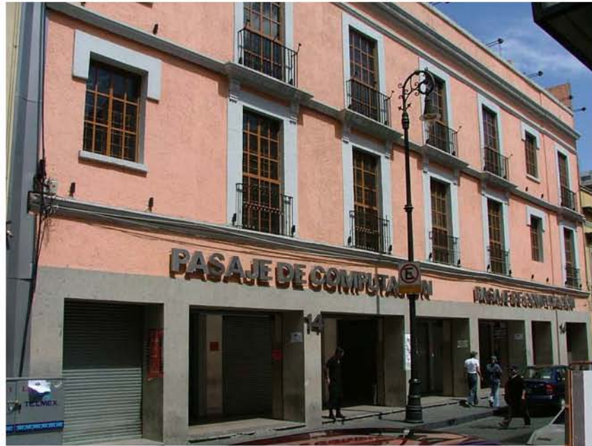
EDIFICIO NUEVO VENUSTIANO CARRANZA
