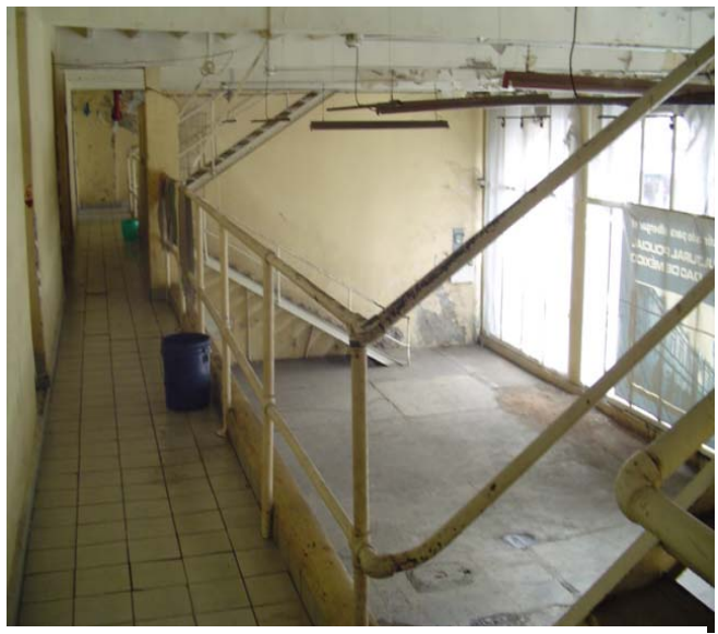
Lámina 55. Vista del entrepiso en donde se hallaban las bodegas y pajares.
