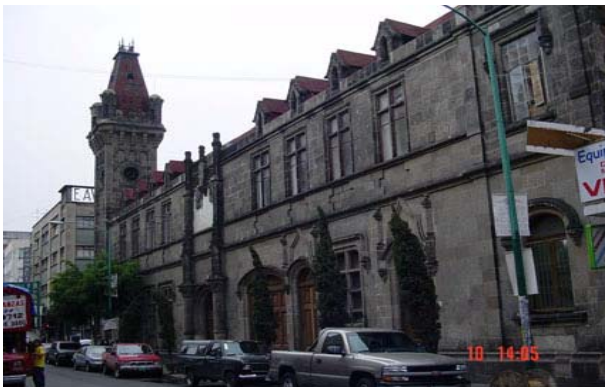
Lámina 68. Edificio de la Sexta Inspección de Policía visto desde la acera surponiente de la calle de Revillagigedo.
