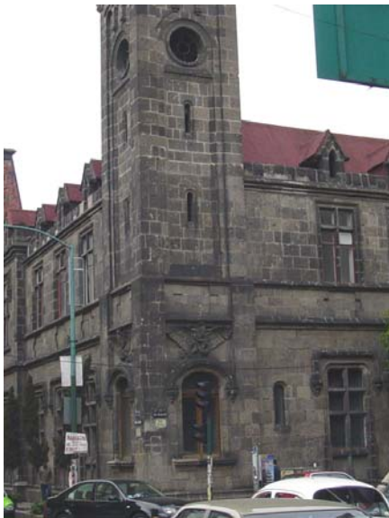
Lámina 96 (izquierda). Ventanas de arco de medio en la base de la torre y las lucarnas que, con sus vanos ojivales y sus gabletes, coronan a todo el edificio
