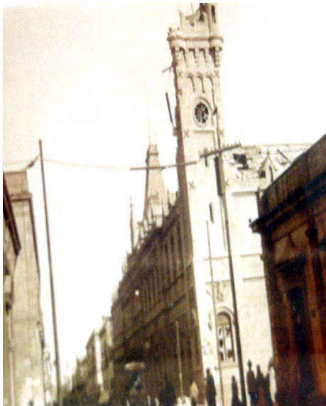
Lámina 98., Daños a la torre vistos desde la acera poniente de la calle de Victoria;
