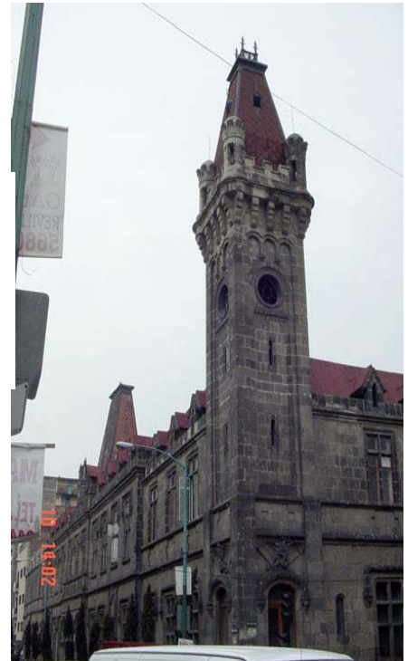
Lámina 84. Vista actual de la torre.
