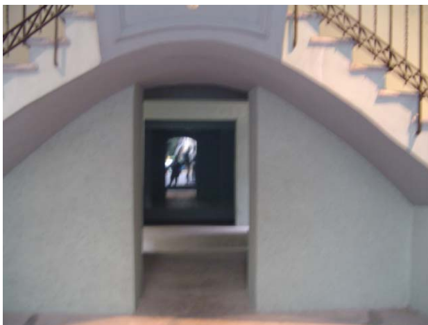
Lámina 48. Acceso a la Sala de Juntas desde la calle de Revillagigedo
