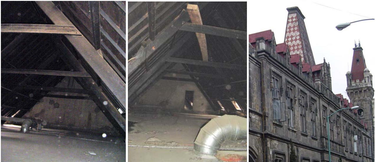
Lámina 85, 86 y 87. Izquierda y centro, se puede observar el ante techo hecho a base de concreto y el techo a dos aguas con su armazón de madera que aún se conserva. A la derecha, se observan las buhardillas que proporcionaban luz y ventilación suficiente al interior del techo.
