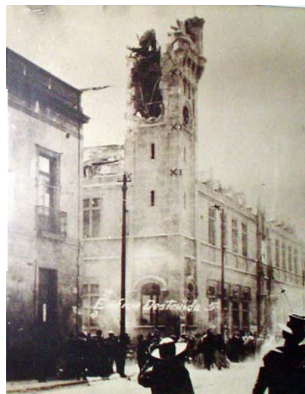
Lámina 99. Daños de la torre vistos desde la acera norte de la calle de Revillagigedo.
