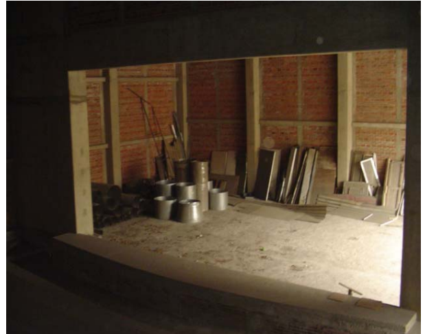
Lámina 61. Interior de la sección de caballerizas, lado sur.
