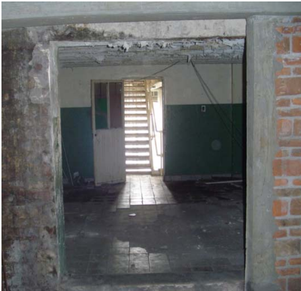
Lámina 56. Vista del interior de una bodega del entrepiso, al fondo la escalera que conducía a los dormitorios de bomberos.
