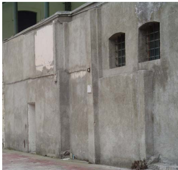
Lámina 92. Ventanas utilizadas en la parte de lo separos.
