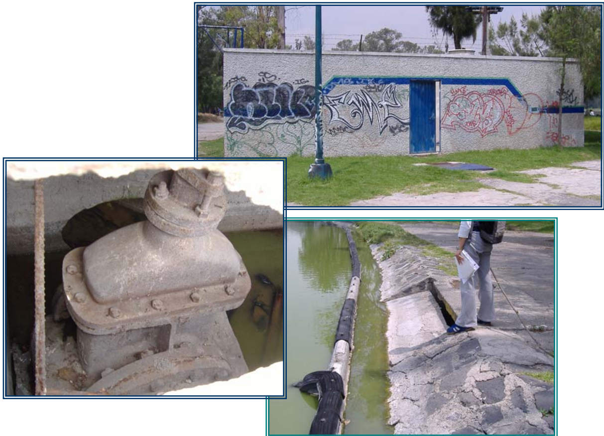
Figura 2.20. Planta de bombeo y obra de excedencias del lago del BSJA.
