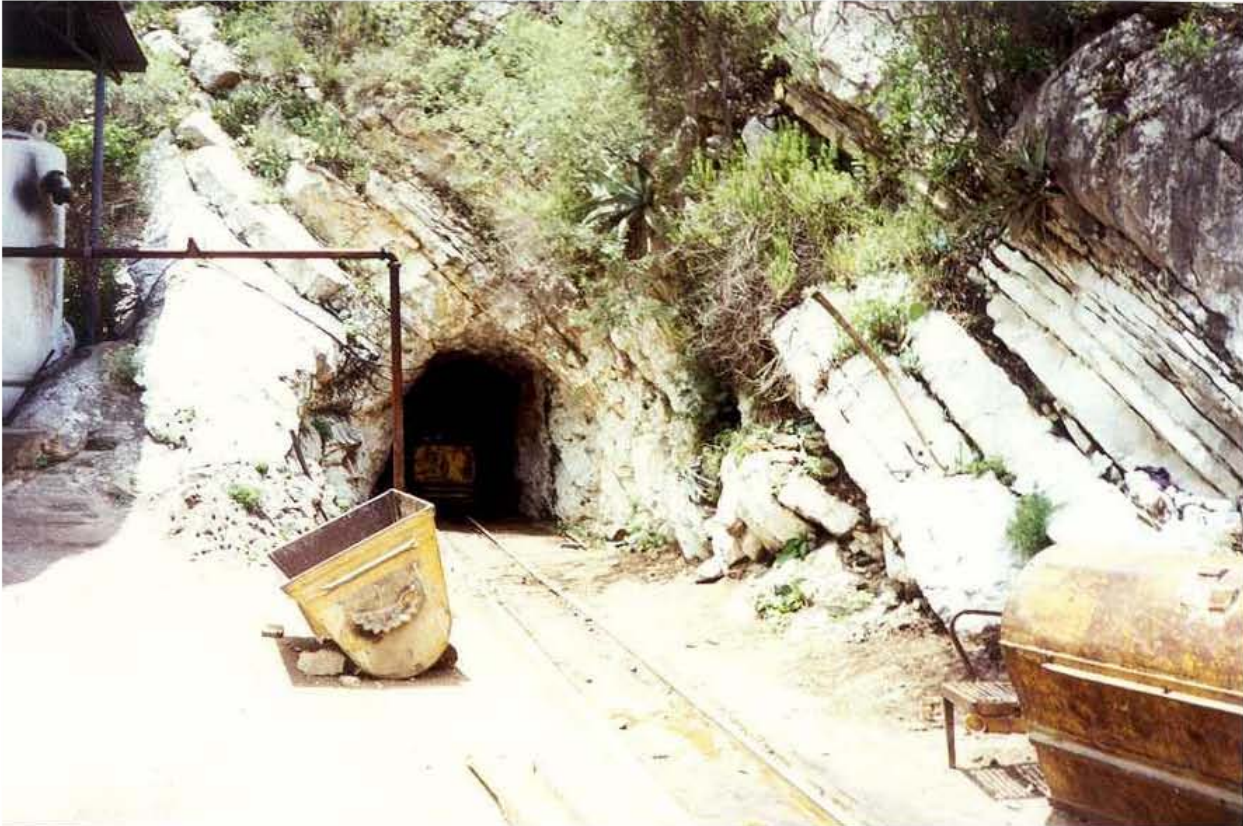
Fotografía 15.- Distrito minero Santa Rosa "Mina El Palmito". Espesor del manto 2 a 3 m, producción 550 Ton/mes; ley: 70 % de sulfato de bario; densidad de 3.95.
