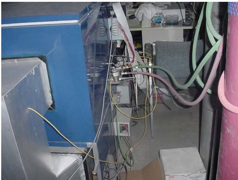
Figura 4.6 Se muestra la parte posterior de la cámara de corrosión donde se encuentran las tarjetas y se pueden apreciar las electro-válvulas que permiten la entrada de los gases.
