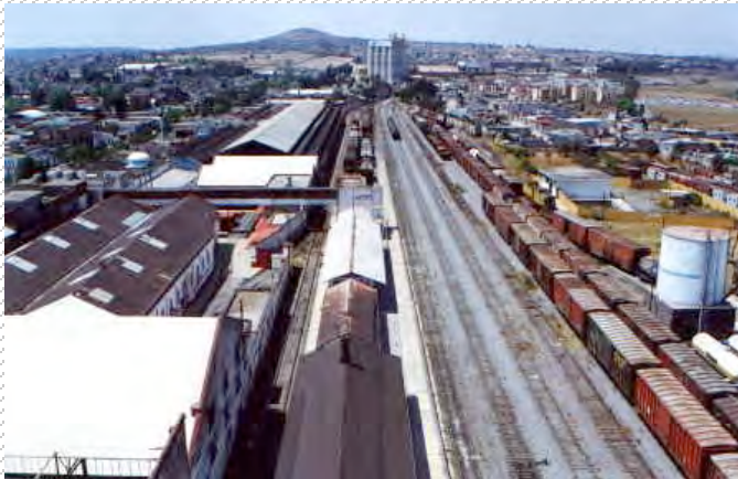
Vías ferroviarias de Apizaco
