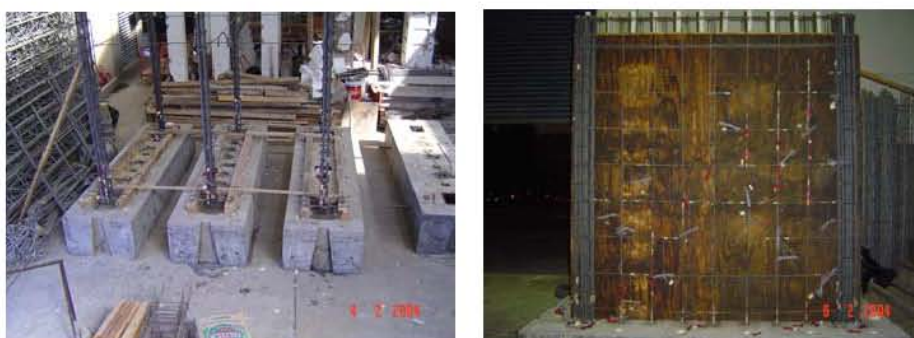
Figura 3.1 Construcción de los muros y su instrumentación
