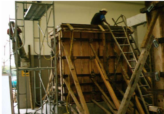
Figura 2.7 Cimbrado los muros antes de ser colado
