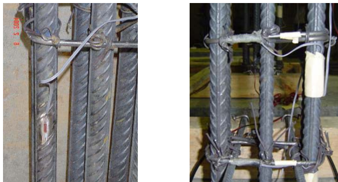
Figura 2.9 Instrumentación interna de los barras de refuerzo
