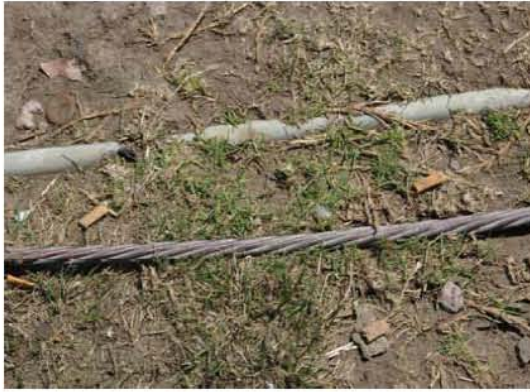
Figura 5.4.2a. Cable hacia la DELTA y Barra de tierra TMGB.
