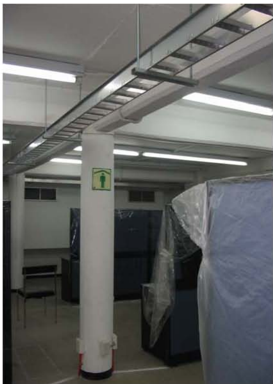
c) Canalización Horizontal sobre áreas de trabajo.
