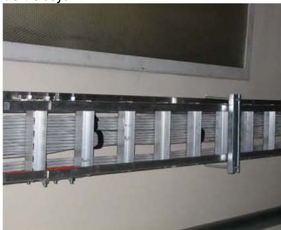
c) Canalización Horizontal sobre áreas de trabajo.
