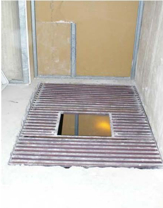
a) Adecuaciones a la superficie
