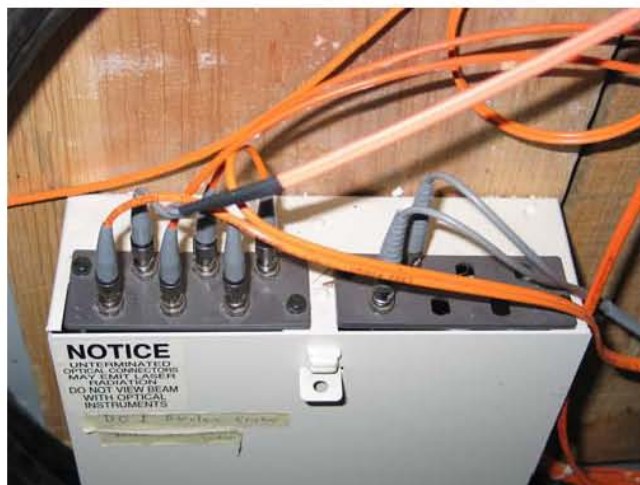
Figura 5.4b. Acometida de fibra de ocho hilos de RedUNAM.
