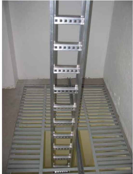
b) Instalación de la Canalización
