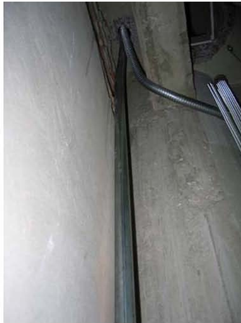
Figura 5.4.2c. Vertical de las tierras físicas paralela y separada por la trabe a la vertical de canalización de cableado de la RedDGB.
