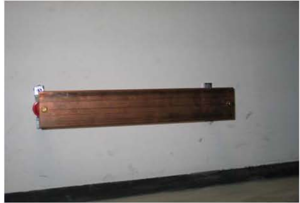
Figura 5.4.2a. Cable hacia la DELTA y Barra de tierra TMGB.
