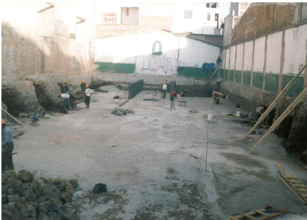
Foto 5.2 Vista general de la excavación del predio.
