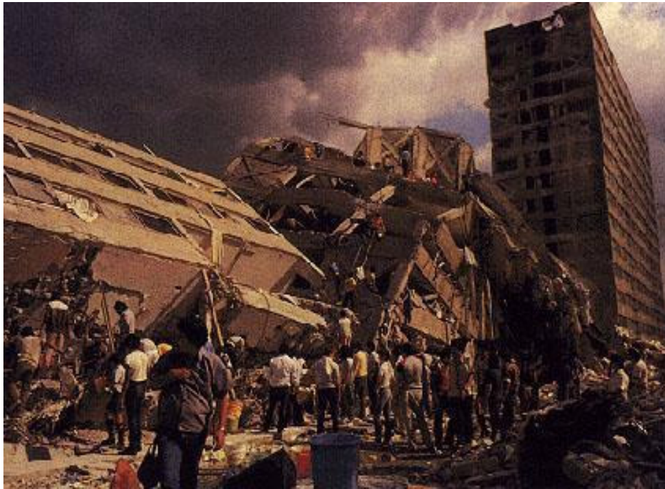
Foto 4.2 Falla general de la cimentación de un edificio en la Ciudad de México en el sismo del 19 de septiembre de 1985.
