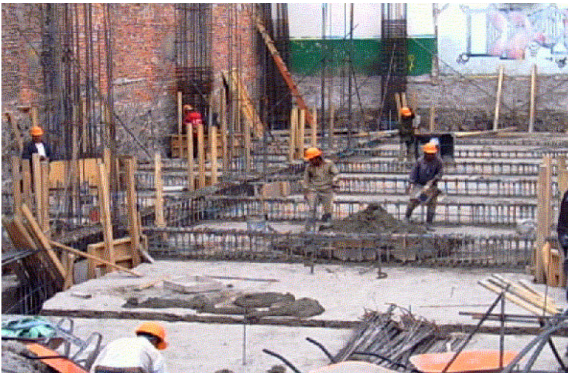
Foto 5.6 Vista general de la construcción del cajón de cimentación
