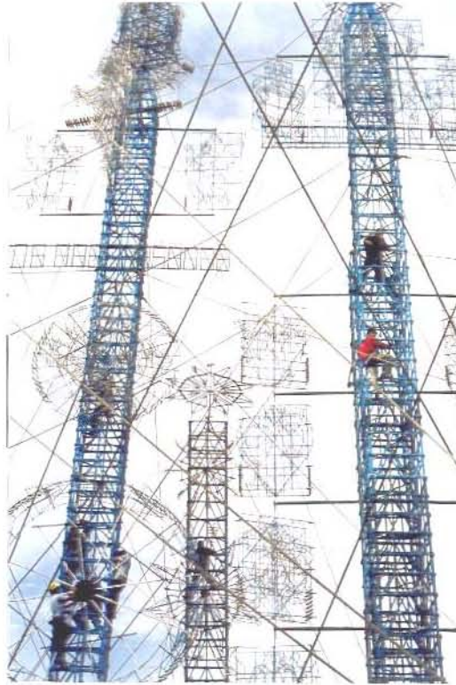
Instalación de los castillos.
