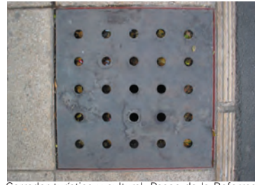
Corredor turístico y cultural ,Paseo de la Reforma mobiliario urbano, coladera, enero 2005.
