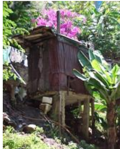
El paseo a la margen del río, está en desuso debido a los malos olores generados por el drenaje a cielo abierto de los asentamientos humanos a pie de ladera.
