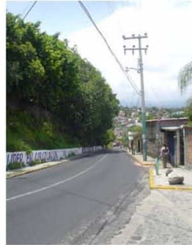
Vialidad Local Agustín Lara Pavimento de asfalto con dos carriles, cada sentido de un carril y secciones de aceras de 0.80 m. a 1.00 m.
