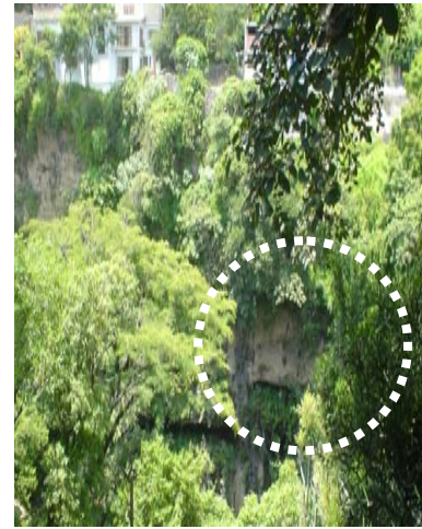
Drenaje a cielo abierto, ocasionado erosión hídrica perturbando el ecosistema de selva baja
