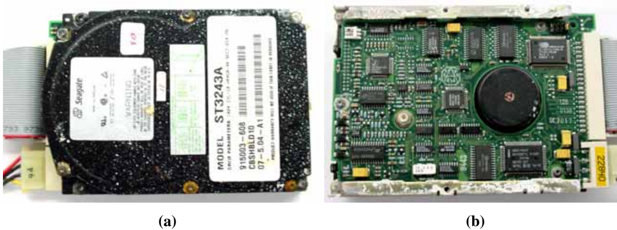
Figura 4.19 (a) En esta imagen es notorio el deterioro sufrido sobre la carcasa de disco, así como el óxido existente en los tornillos. (b) Vista de la Tarjeta controladora del disco en donde se aprecia el daño sufrido en el soporte de sujeción así como en circuitos integrados principalmente.
