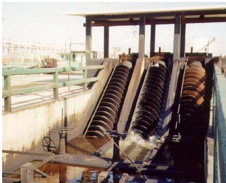
Figura 2.2 Transportadores de tornillo.
