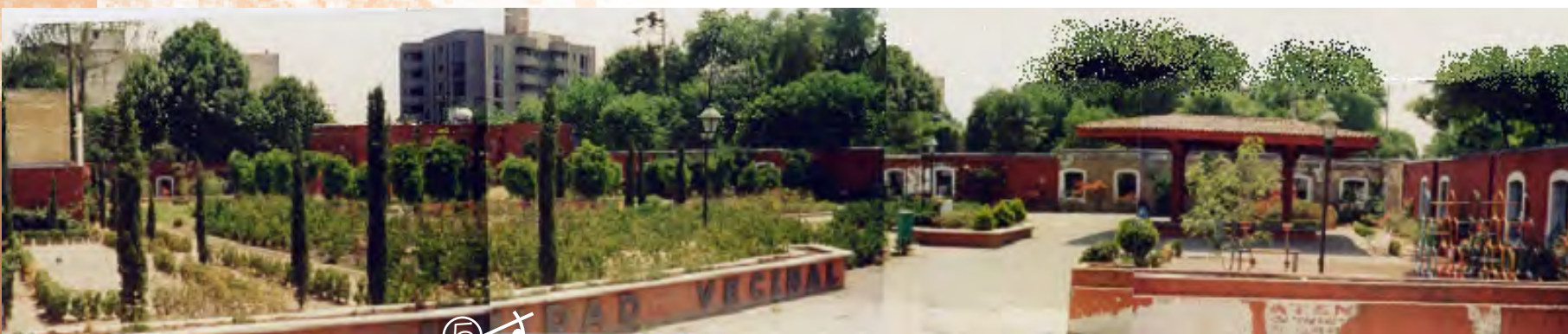
Vista al interior del terreno. No existe ningún diseño en particular que determine una completa integración con el contexto y por consiguiente no cuenta con los espacios adecuados para contener a la gente, de esta manera el terreno se convierte en un espacio inservible puesto que ninguna persona se siente atraída para acceder a él y disfrutarlo.
