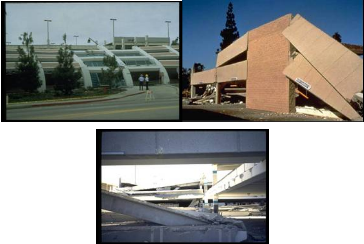
Figura 2.4. Colapso de estructuras debidas a falla en el sistema de piso.
