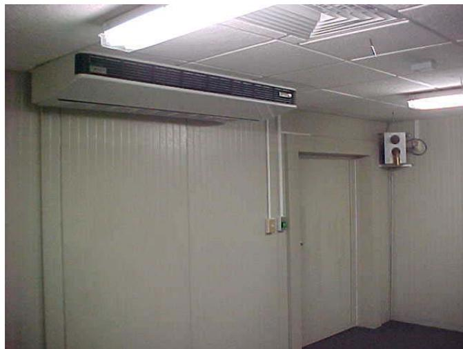
Fotografía No.23.- Imagen que muestra el interior de la cámara fría y de confort, donde se observa el “minisplit”, el acceso a la cámara y el humidificador. Dicha cámara es parte del Laboratorio de Ambiente Controlado de la UAM-Iztapalapa.
