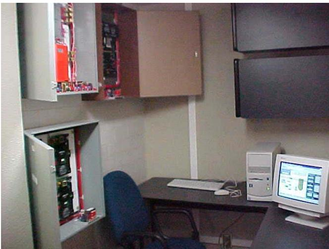
Fotografía No.27.- Área de trabajo del cuarto de control donde se monitorean y se controlan a través de la computadora, las condiciones ambientales tanto de la cámara fría y de confort, como de la cámara caliente.
