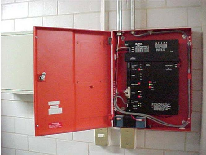
Fotografía No.30.- Imagen que muestra el cerebro o tarjeta principal de control, el cuál se encuentra ubicado en el cuarto de control del Laboratorio de Ambiente Controlado.
