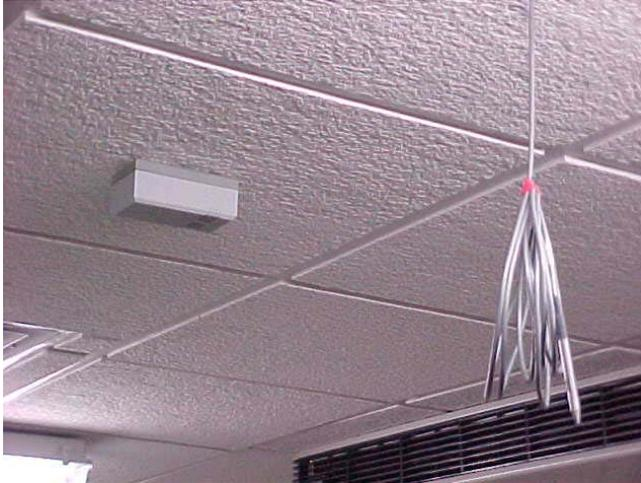
Fotografía No.28.- Imagen donde se observa el falso plafond de la cámara fría y de confort, del lado izquierdo se encuentra el sensor de CO<sub>2</sub> y del lado derecho el sensor de temperatura, el cuál puede ubicarse a diferentes niveles sobre el nivel del piso de la cámara.
