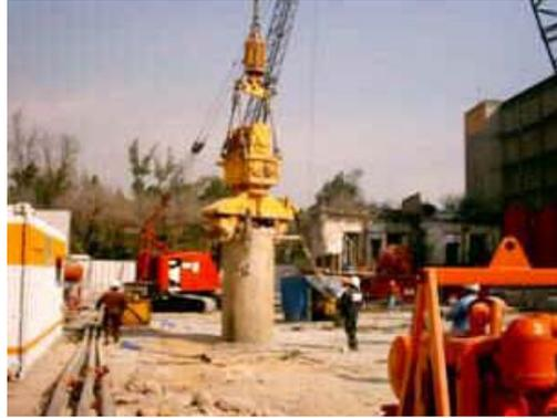
Una vez instalado el ademe tubular, se recupera el brocal inicialmente colocado y se concluye la perforación, continuando su estabilización con lodo bentonítico hasta alcanzar el estrato considerado como apoyo localizado a la profundidad adecuada.
