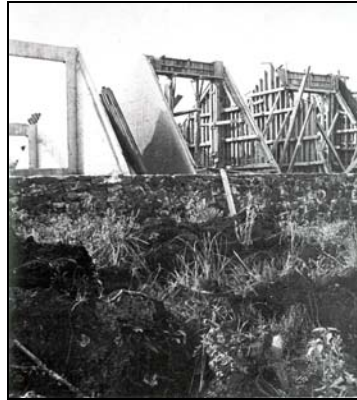
Construcción de los prismas.
