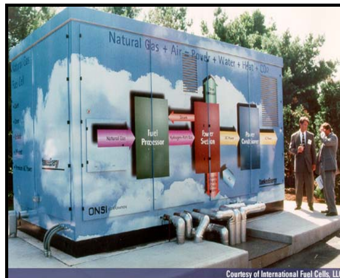
Figura 2.3 Estación Generadora de Celda de Combustible MCFC.
