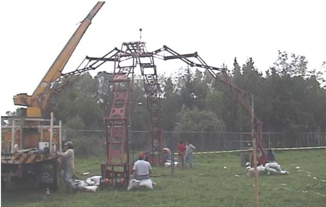
Fig. 6.33 Posición intermedia del izado
