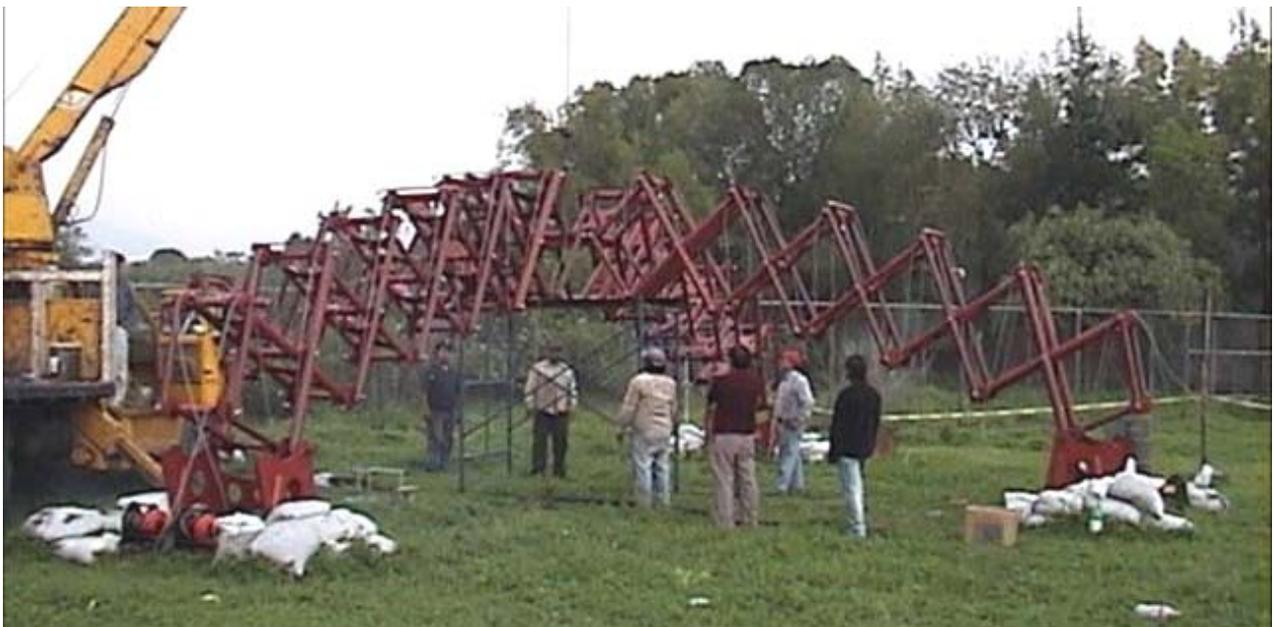
Fig. 6.32 Posición intermedia del izado
