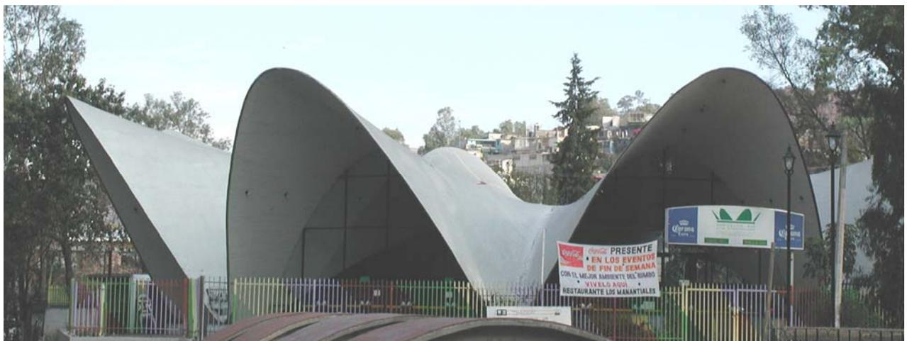
Fig. 1.3 Cascarón de doble curvatura inversa
