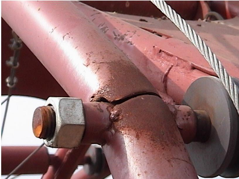
Fig. 6.40 Plastificación y ruptura en fibras a tensión
