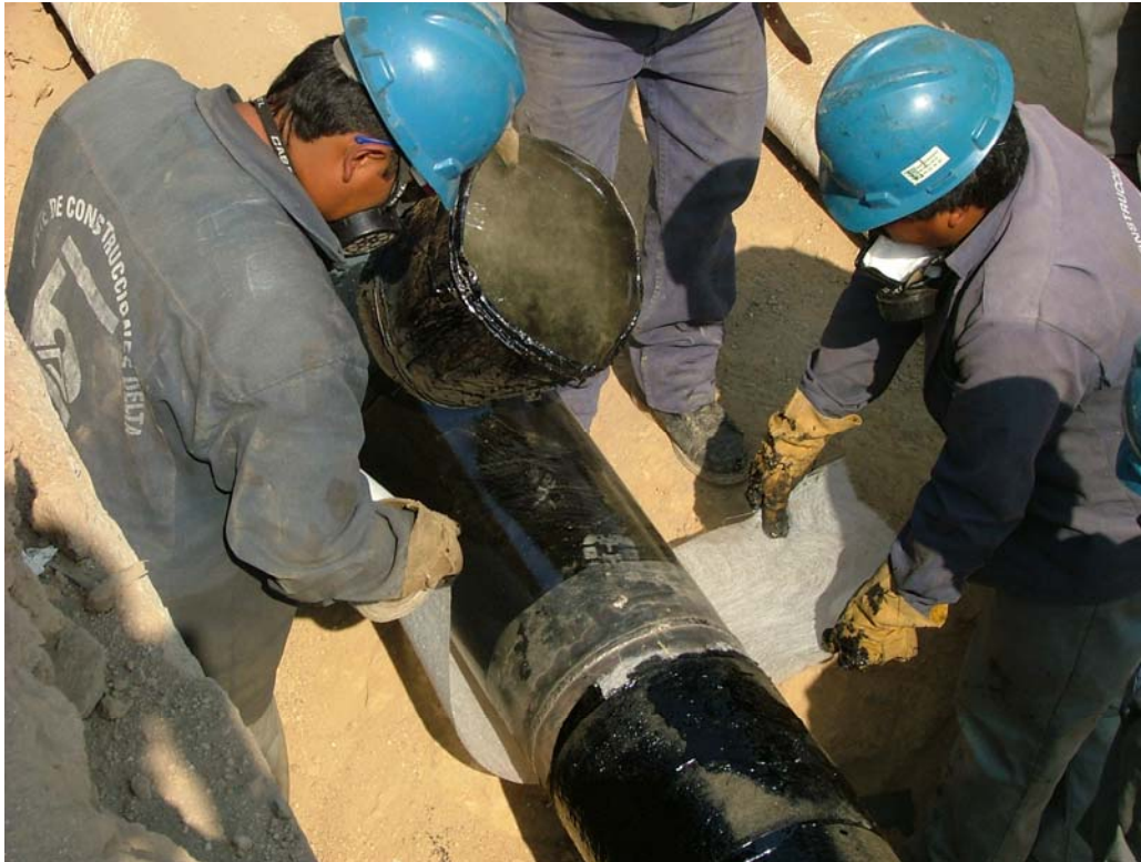
PARCHEO DE JUNTA SOLDADA
