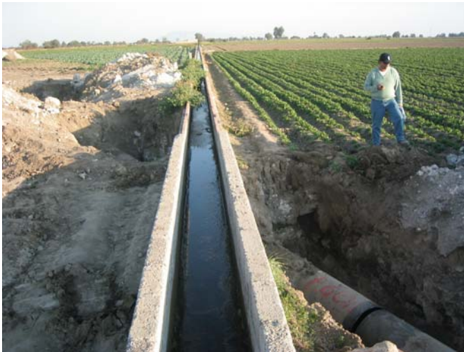
AFECCIÓN EN ZONA DE CULTIVO
