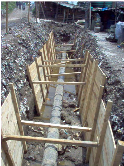
TIPO DE ADEME PARA EXCAVACIÓN
