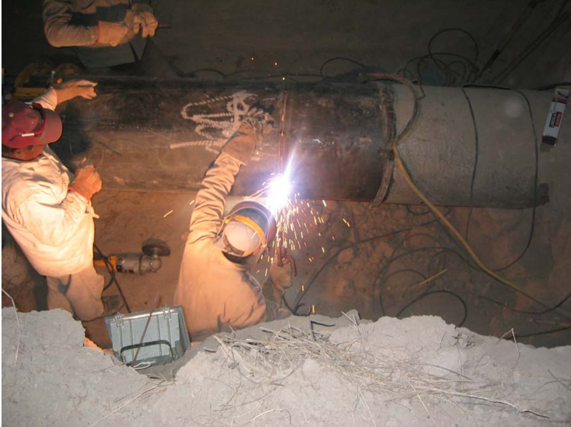
PROCESO DE SOLDADURA
