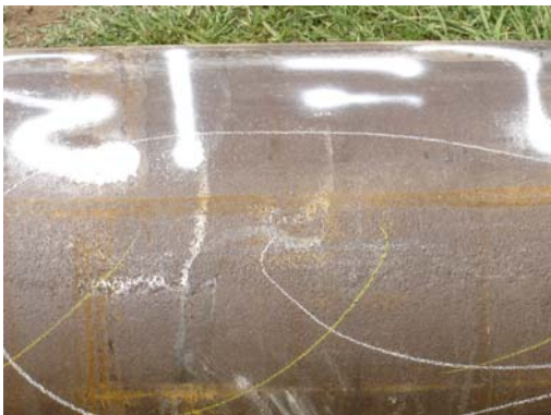
INSPECCIÓN VISUAL AL TUBO
