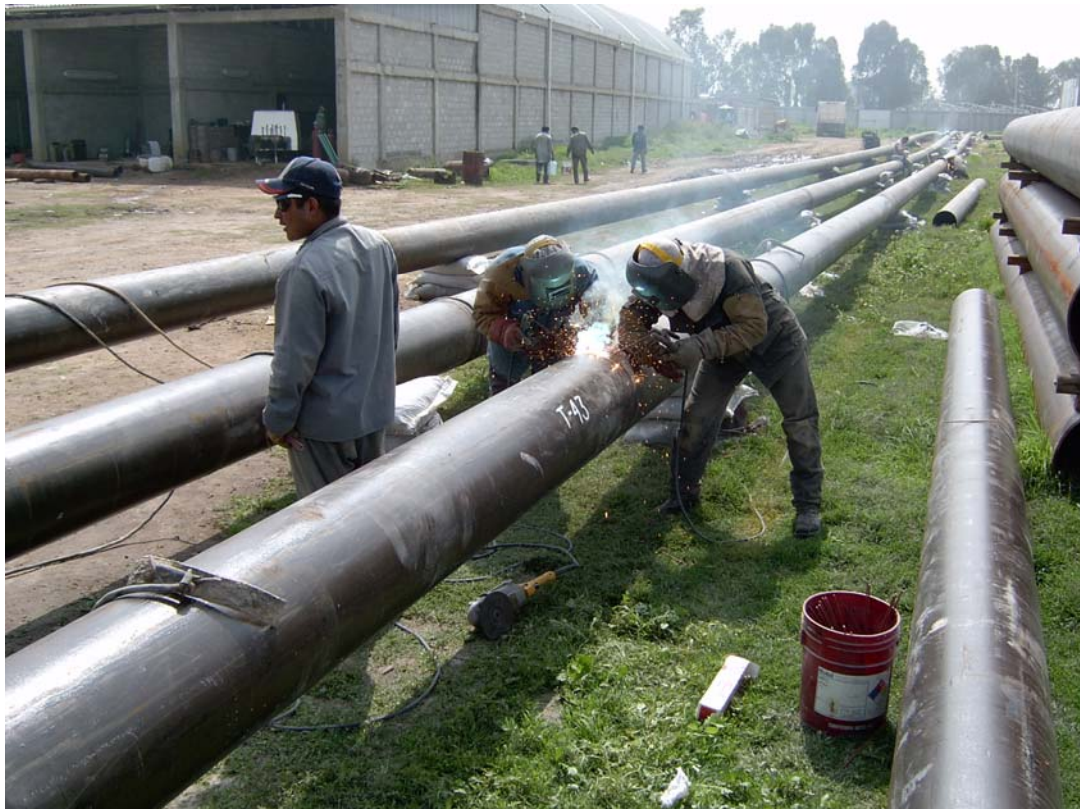
SOLDADURA PARA UNIÓN DE LINGADA PARA PRUEBA HIDROSTÁTICA
