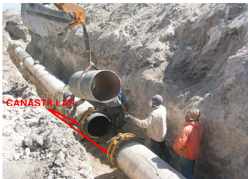
ALINEACIÓN CON CANASTILLA PARA EL PUNTEO DEL TUBO
