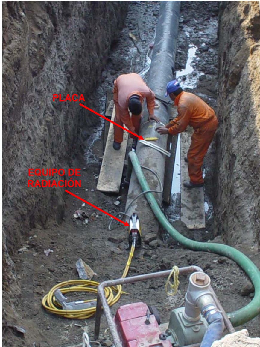
COLOCACIÓN DE PLACA PARA RADIOGRAFÍA CON EQUIPO DE RAYOS GAMA
