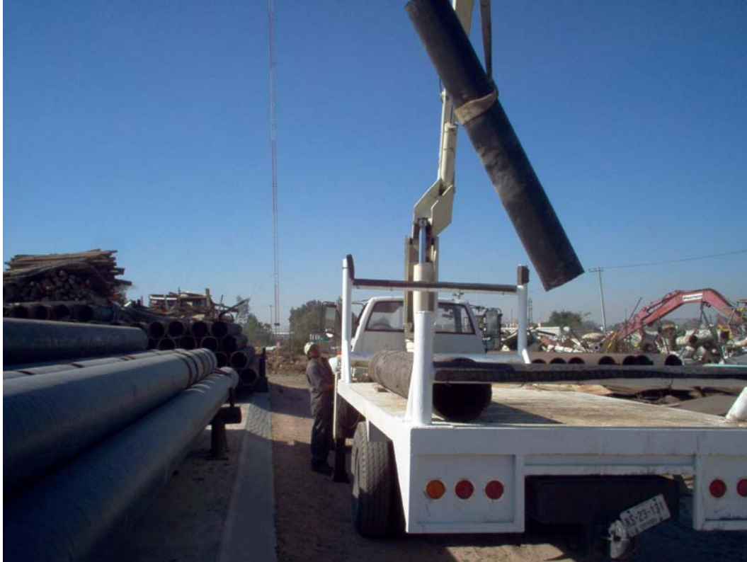
ESTIBA DE LA TUBERÍA
