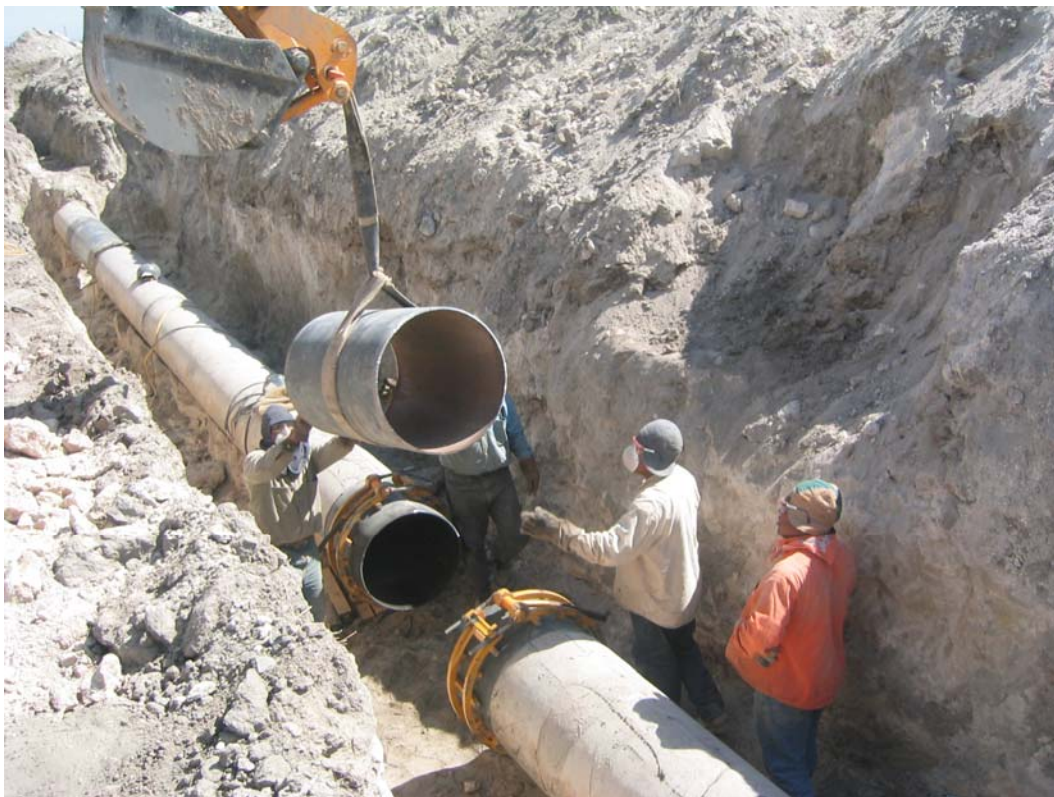
REHABILITACIÓN POR SUSTITUCIÓN DE TRAMOS DE TUBERÍA DEL MISMO DIÁMETRO
