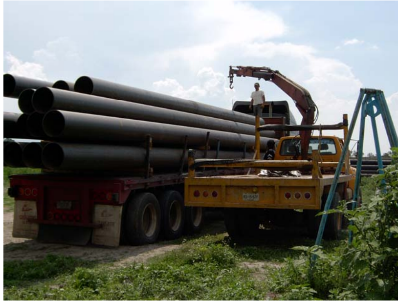
TUBERÍA RECUBIERTA LISTA PARA SER REPARTIDA A LAS EXCAVACIONES
