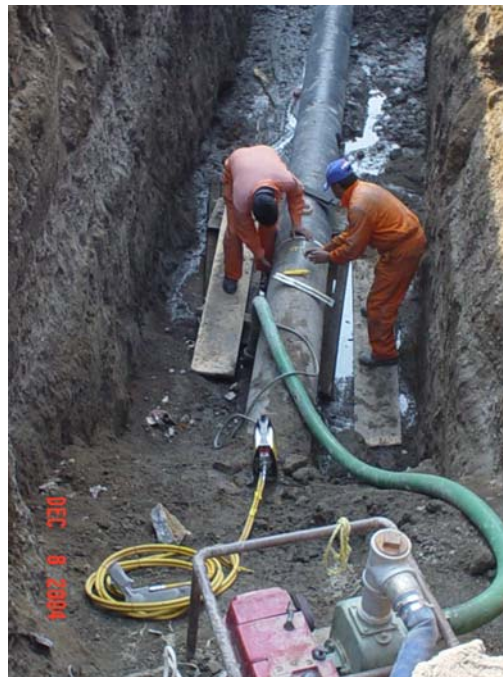
PRUEBA DE SOLDADURA (RADIOGRAFÍA)
