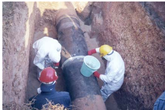
APLICACIÓN DE PASTA CERTITE EN LOS EXTREMOS DE LA ENVOLVENTE
