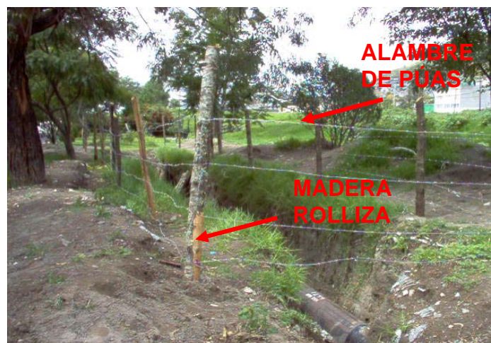
CERCADO CON ALAMBRE DE PÚAS
