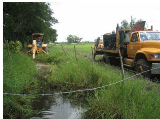
MAQUINARIA PARA EXCAVACIONES
