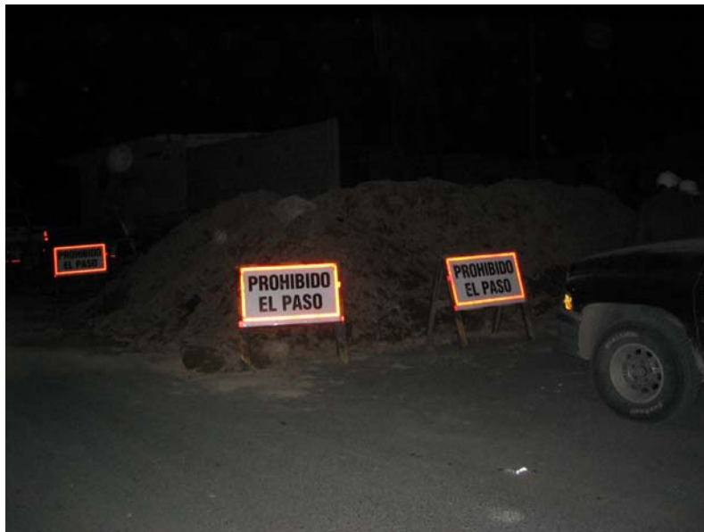
SEÑALIZACIÓN PREVENTIVA DE EXCAVACIÓN
