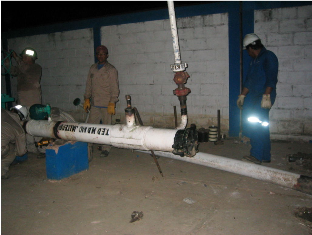
INYECCIÓN DE NITRÓGENO EN LA TRAMPA DE DIABLOS
