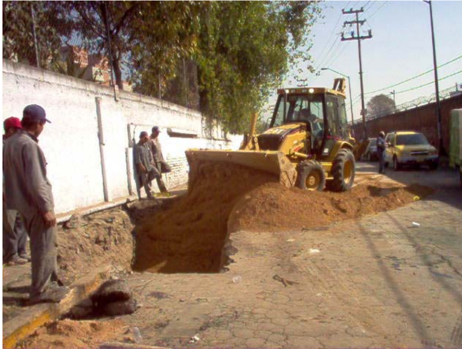
RELLENO DE EXCAVACIONES
