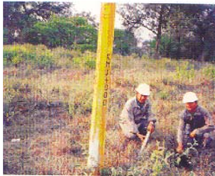
SEGUIMIENTO SUPERFICIAL DEL DIABLO INSTRUMENTADO
