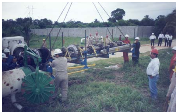
INTRODUCCIÓN DE DIABLO INSTRUMENTADO EN LA TRAMPA DE ENVÍO
