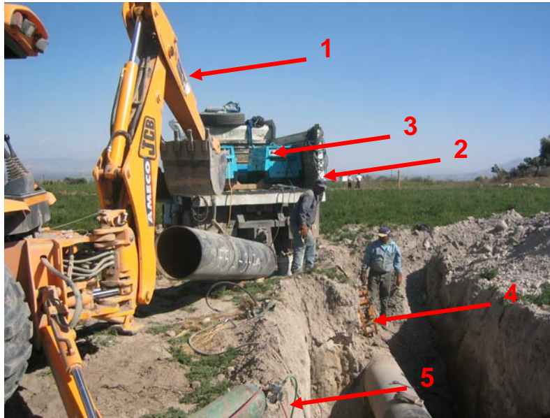
MAQUINARIA PARA REHABILITACIÓN
