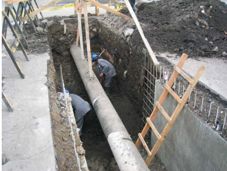
ENCAMISADO DE LA TUBERÍA Y CONSTRUCCIÓN DE TRINCHERA PARA PASO VEHICULAR
