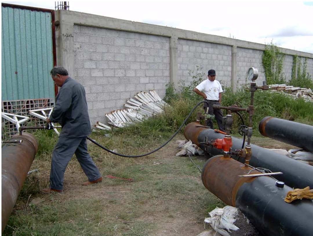
TRABAJOS PREVIOS DE LA PRUEBA HIDROSTÁTICA
