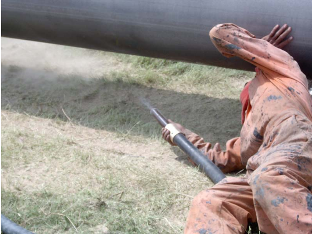
LIMPIEZA CON ARENA SÍLICA (ABRASIVO)
