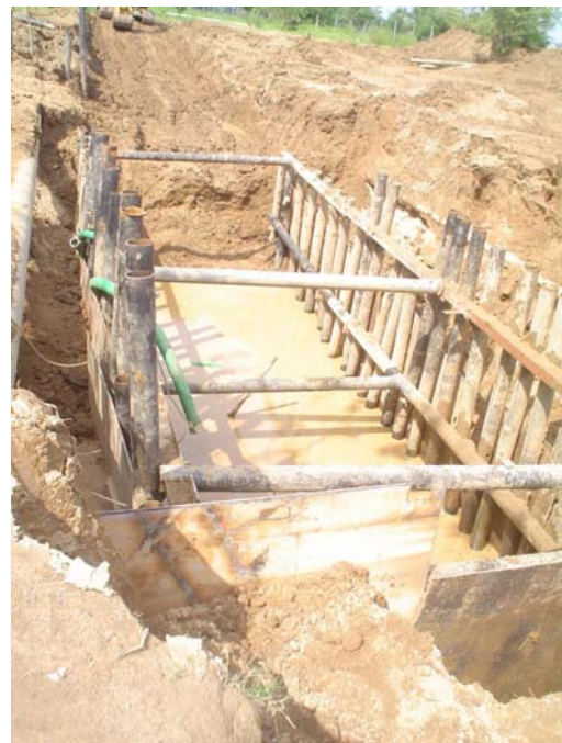
TIPO DE ADEME PARA EXCAVACIÓN
