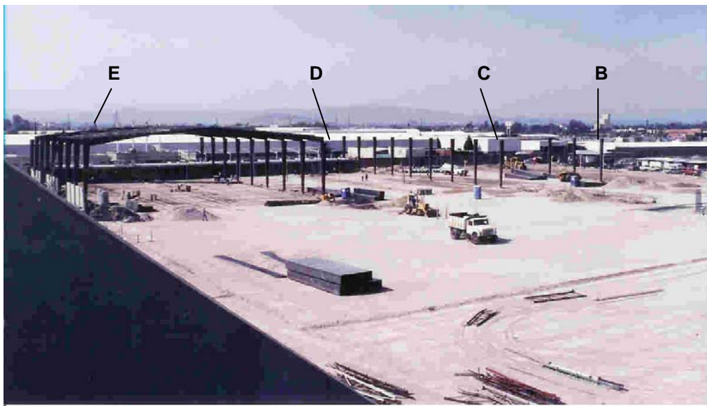
Foto 3.4 Montaje de traves MA-1 entre ejes E y D de 38 m, ver plano 2.3
