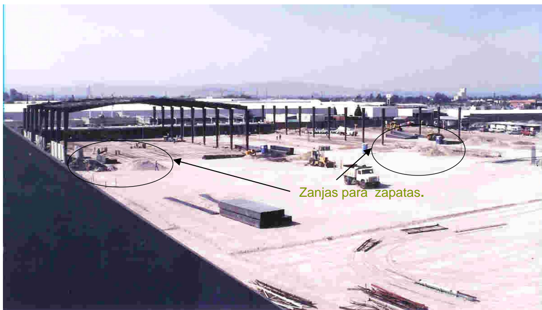
Foto 1.2 Se aprecian montículos de las zanjas para zapatas enfrente de columnas ya colocadas
