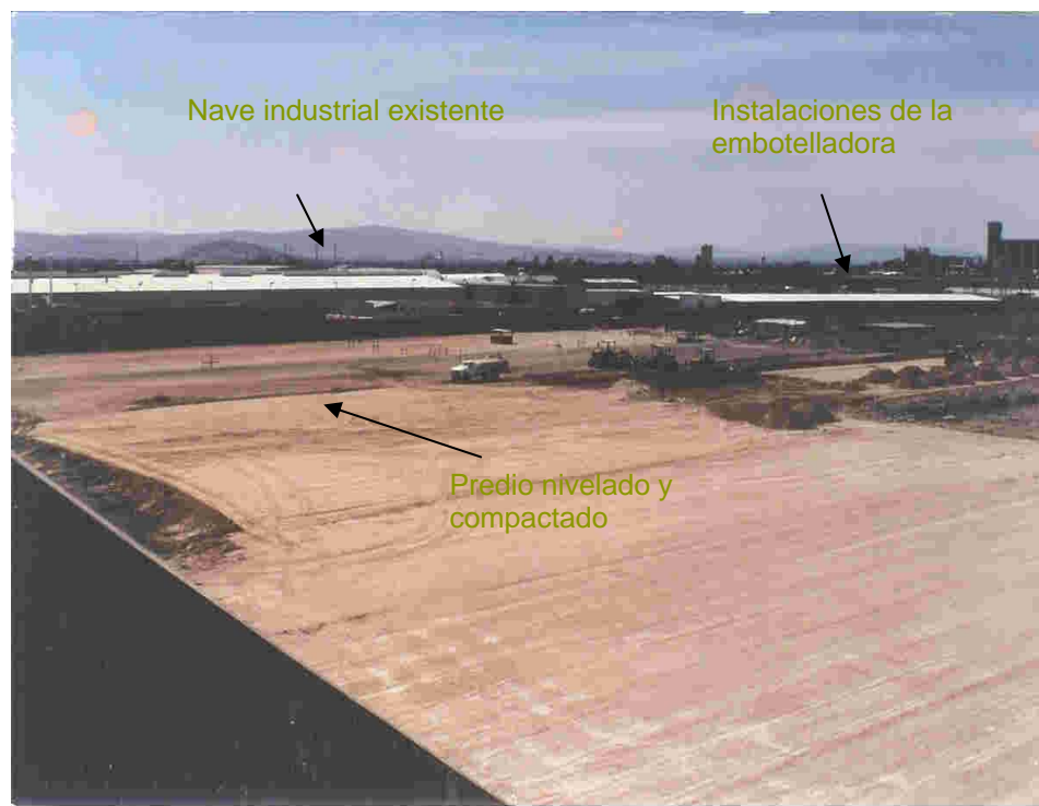
Foto 1.1 Panorámica del predio nivelado, al fondo se aprecia la nave existente propiedad de la misma embotelladora
