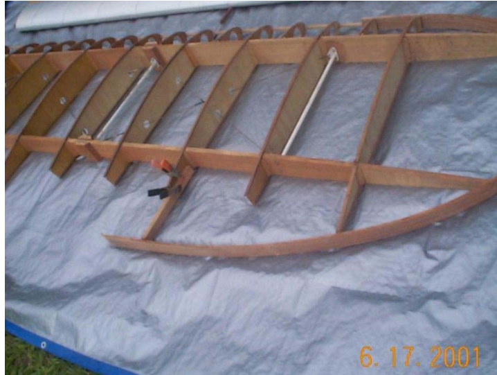
figura 3.6 Construcción de ala de madera
