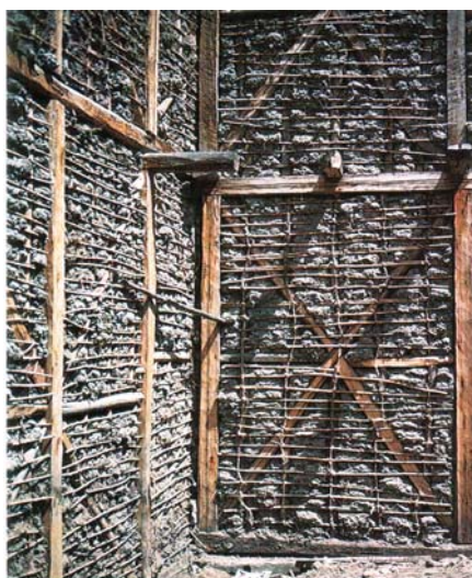
Figura 21. Construcción bajo la técnica de Bahareque (Judziewicz et al 1999).
