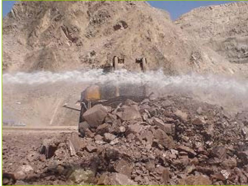
*Fotografía III.9. Mediante el uso de tractor, se dispone el material con el espesor especificado. Continúa la humectación.*
