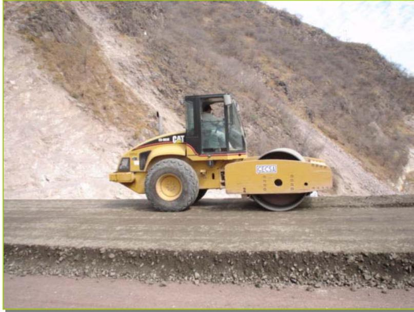
*Fotografía III.4 FINALMENTE, EL COMPACTADOR DE RODILLO LISO VIBRATORIO, PROPORCIONA EL GRADO DE COMPACTACION SOLICITADO.*
