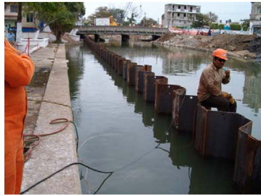
Foto No. 2 Tablestacado en un canal
