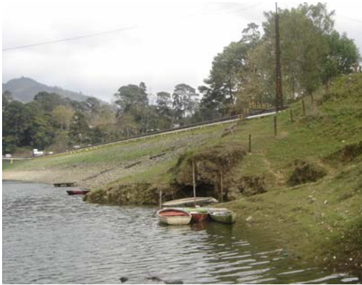
Foto No. 1 Presa de tierra y enrocamiento
