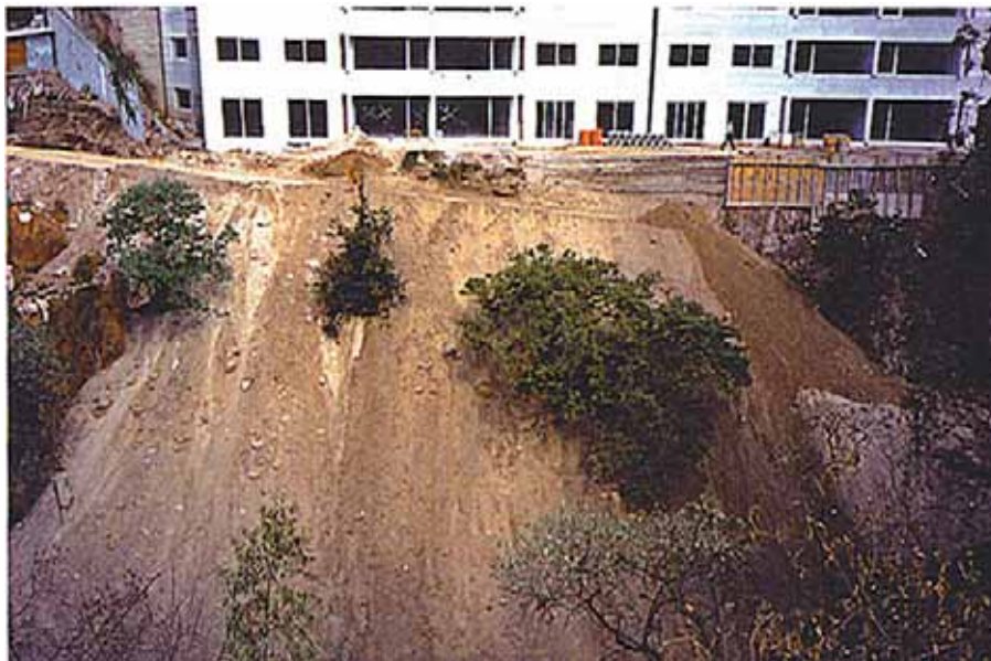
Foto 2. Construcción de edificios en la barranca de Bezares.
