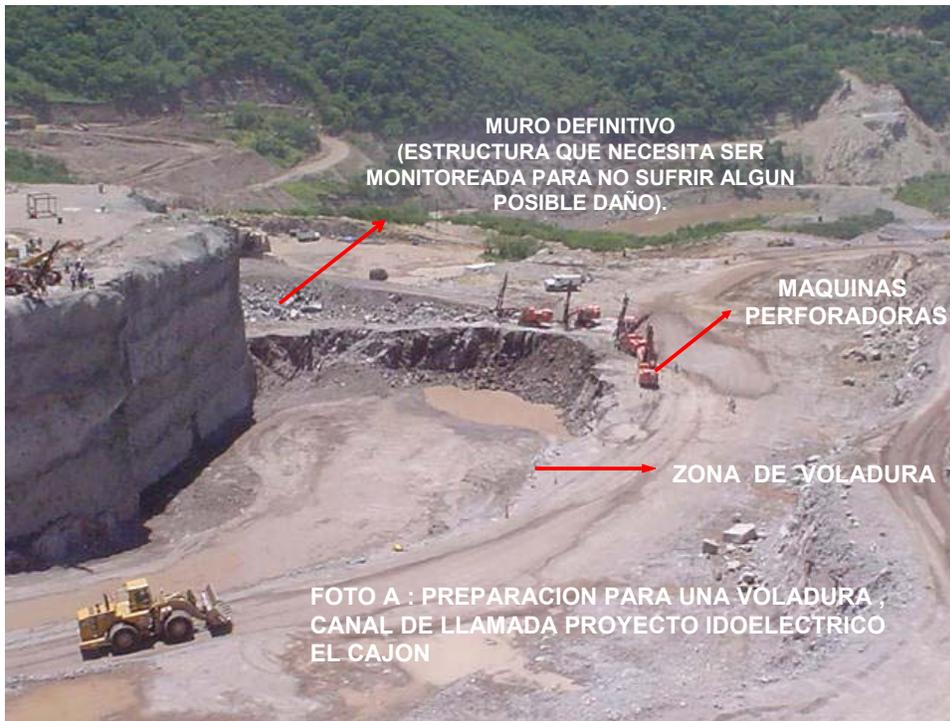
Se mide la distancia que existe entre el sitio de la voladura y los muros que se pretenden cuidar, se recaba información de estos para saber de las edades de los concretos y sus resistencias.
