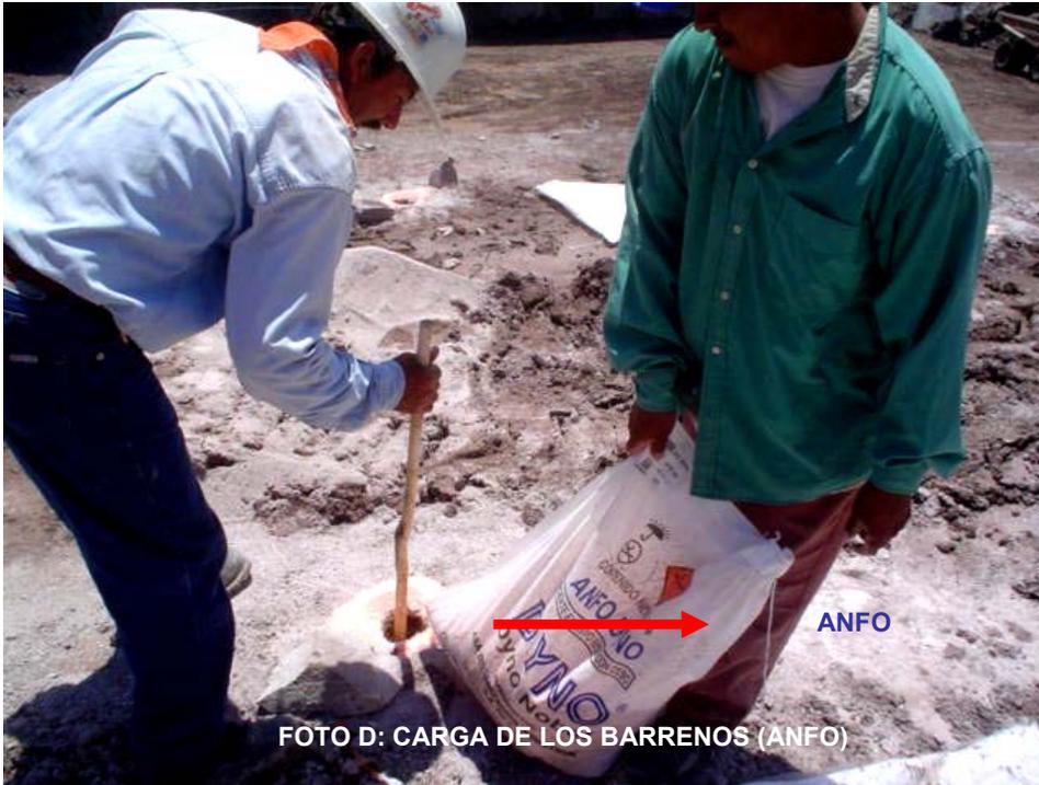
Cuando el explosivo ya es colocado se realiza el taco, esto es un tapón del material obtenido de la barrenación.
