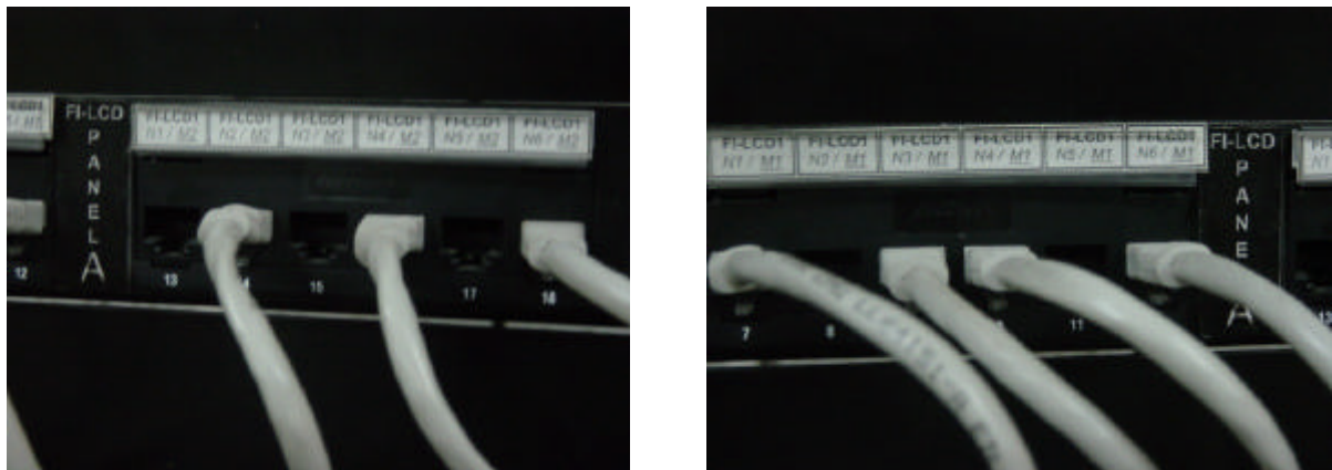
Fig. 2.11 - Conexiones frontales en el centro de distribución
