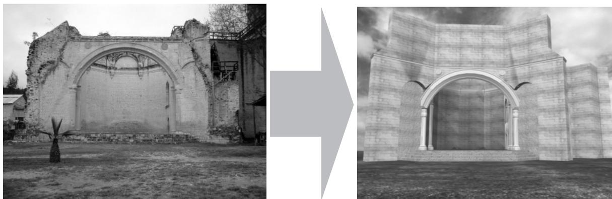
Figura 4.21 estado actual y modelo con los muros y arcos botareles completados
