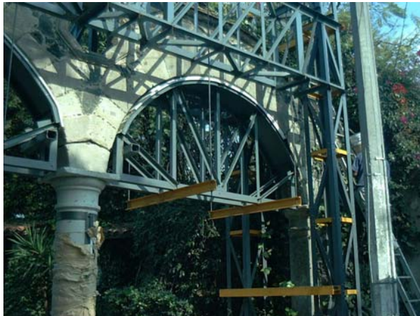
ESTRUCTURA METÁLICA LIBERADA FOTOGRAFÍA 4.18
