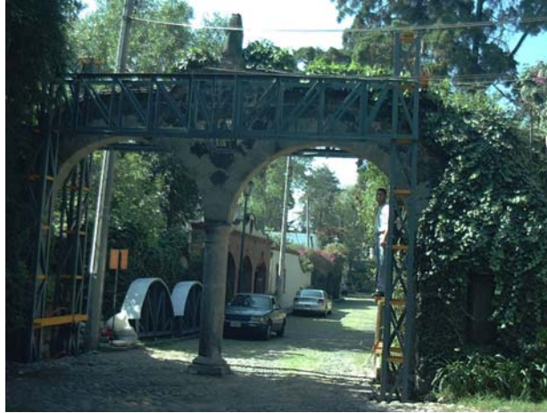
ESTRUCTURA MONTADA POR GRÚA FOTOGRAFÍA 4.7
