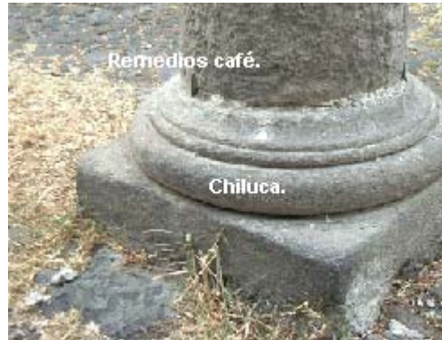
PEDESTAL DE LA COLUMNA CENTRAL FOTOGRAFÍA 2.4
