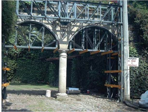
ESTRUCTURA METÁLICA (ANTES DE COLOCAR PIEZA CENTRAL) FOTOGRAFÍA 4.9
