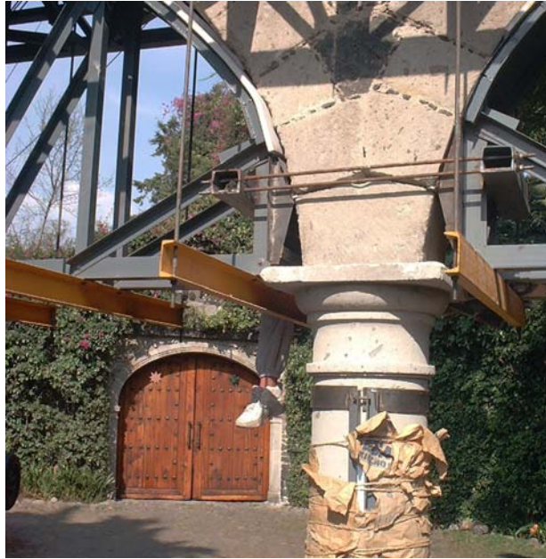
COLADO DE LA JUNTA CENTRAL FOTOGRAFÍA 4.17
