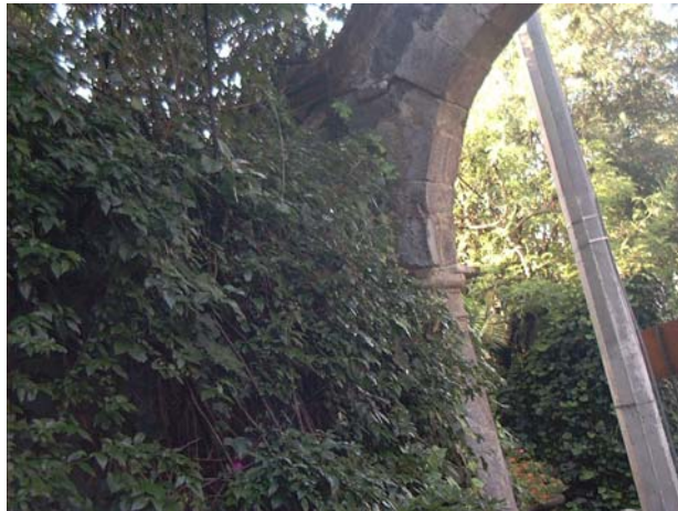
ARCOS DESPLAZADOS (APOYO SUR) FOTOGRAFÍA 4.13
