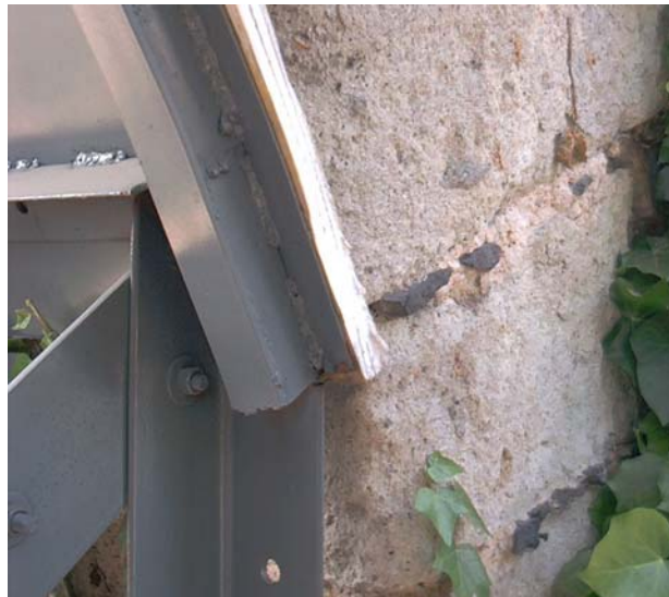
ARCOS SOBRE SUS APOYOS (APOYO NORTE) FOTOGRAFÍA 4.16
