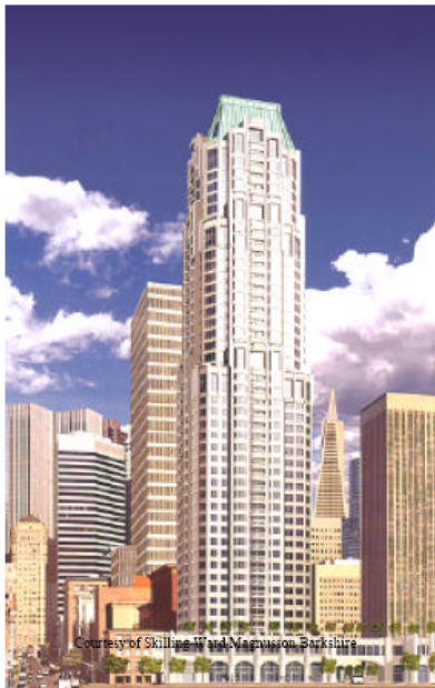
Fig. 1.8-1. Vista del "Century building"
