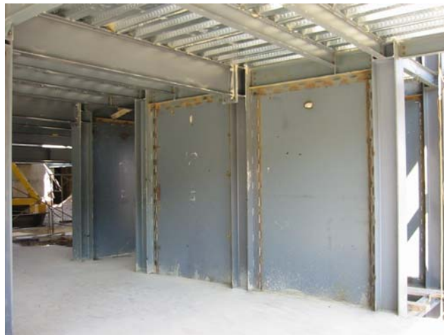
a) Muros de cortante
