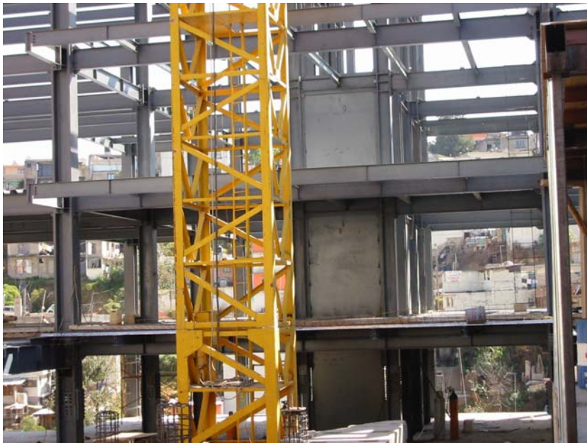
Fig. IN-1. Muros esbeltos de cortante de placa de acero sin atiesar (cortesía de E.M. Ing. Consultores, S.C, México, 2005).
