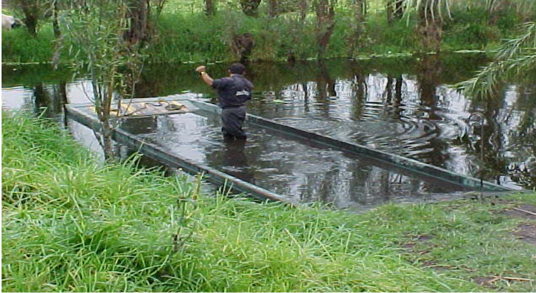
Ilustración 5. Extracción de sedimento en los canales.
