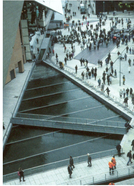
Estanque de recuperación de agua de lluvia en el edificio Daimler-Chrysler de Renzo Piano en la Postdamer Platz, Berlín.
