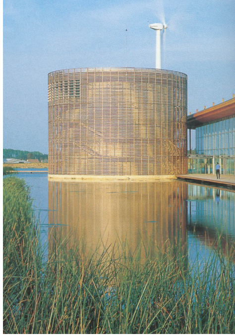
Área de servicio de la Bahía de Somme, Francia. Bruno Mader. El tratamiento de aguas forma parte del ordenamiento paisajístico; el agua es filtrada en separadores de hidrocarburos y son depuradas en los canales por medio de plantas acuáticas.
