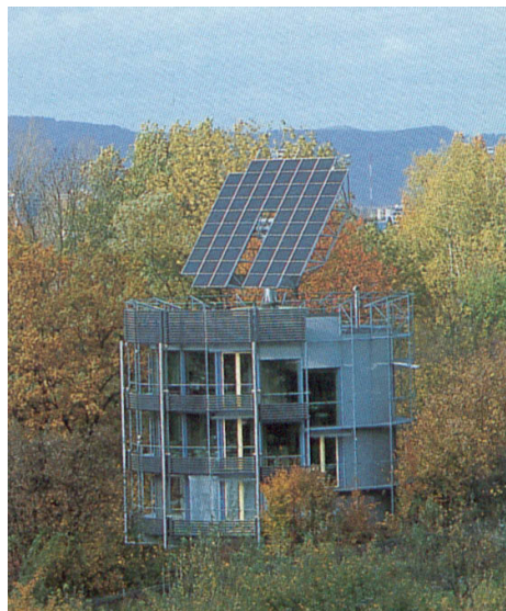
Edificio Heliotropo de Rolf Disch sigue el recorrido del sol girando alrededor de su eje de rotación vertical.
