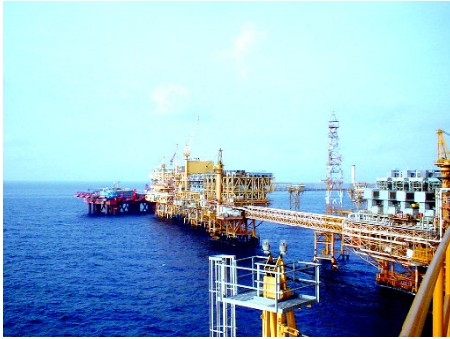
Plataforma de procesamiento de crudo.
