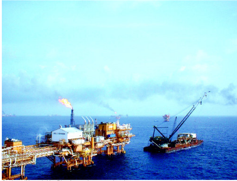
Conjunto Nonoch-Ha: Plataforma de separacion de gases.
