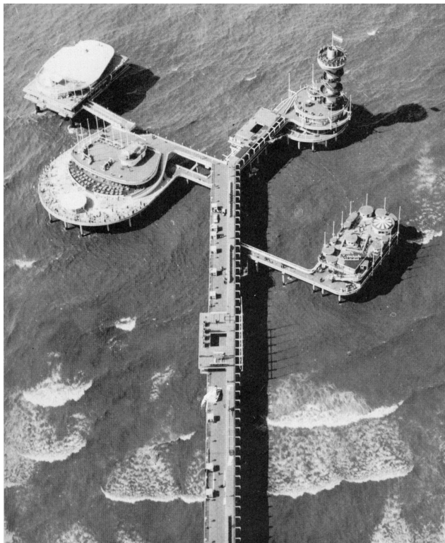
Muelle de Sheveningen, Holanda. Maakant, Dijk y Apen, 1964. Un ejemplo de muelle principal terminado durante el periodo megaestructural y poseedor de una composición libremente informal y funciones resueltamente lúdicas.
