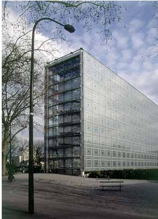
Fig. 16 Fachada del Instituto del Mundo Árabe
