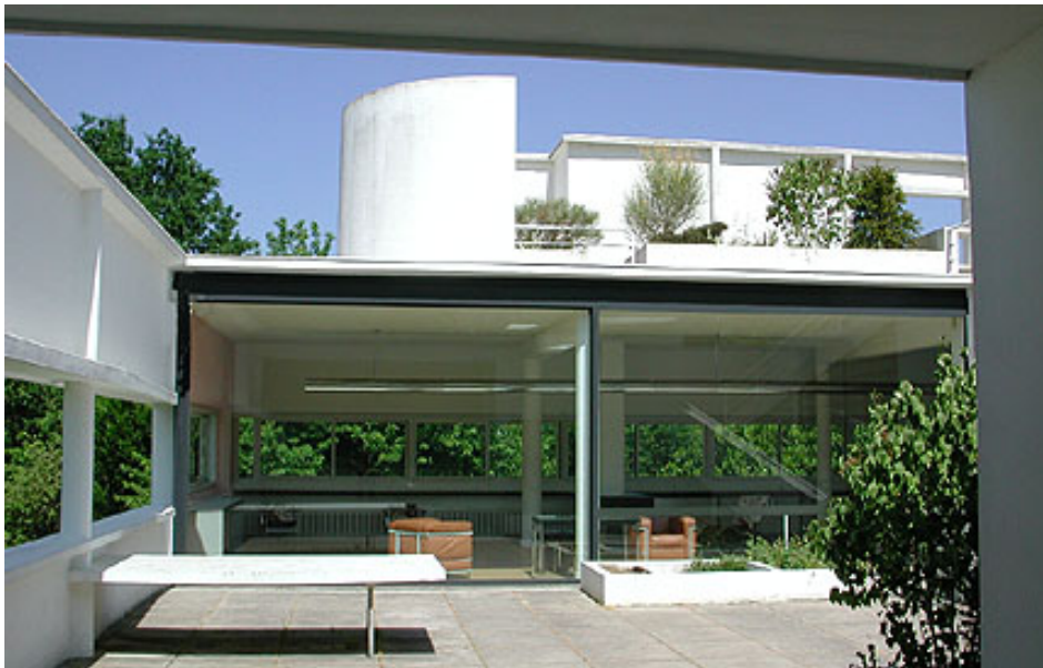
Fig. 19 Villa Savoye de Le Corbusier donde se muestra el uso de las azoteas ajardinadas.
