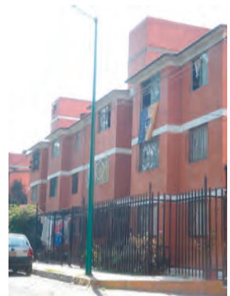
Imágen 2.12. Esta unidad habitacional exhibe falta de espacio interior para brindar servicios suficientes a sus habitantes
