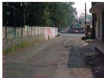
Imagen 2.36. Desemboque de la calle viveros hacia Ave. Tlahuac.
