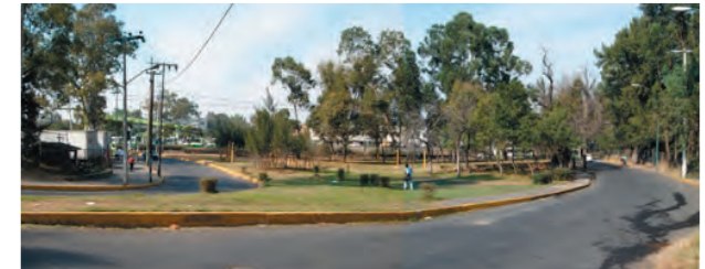
Imágen 2.9. El conjunto de acceso a Periférico no muestra indicaciones claras
