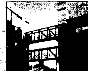
Detalle del Puente
